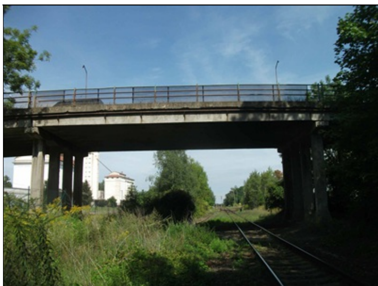
pohled na most zprava, patrná degradace betonu říms nad tratí, prokreslená korodující výztuž
