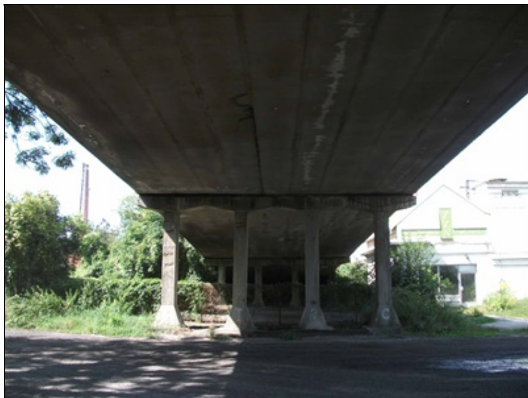
podhled NK - 3. pole, pohled proti směru staničení, prokreslená korodující výztuž pilíře P3
