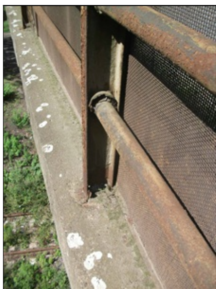
pravá strana, detail zkorodovaného zábradlí
