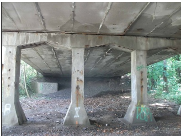
pohled ve směru staničení na pilíř P7 a 7. pole, masivní protékání nosnou konstrukcí, koroze odhalené výztuže a kovových součástí pilíře
