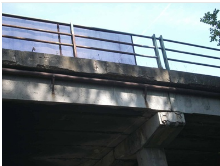
pohled na pilíř P5 zprava, degradace betonu říms, obnažené korodující kotvy předpínací výztuže stativ
