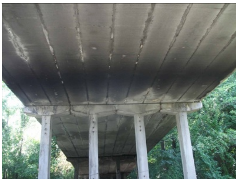
podhled NK ve 4. poli nad tratí, pohled ve směru staničení, spodní líc znečištěn kouřovými zplodinami
