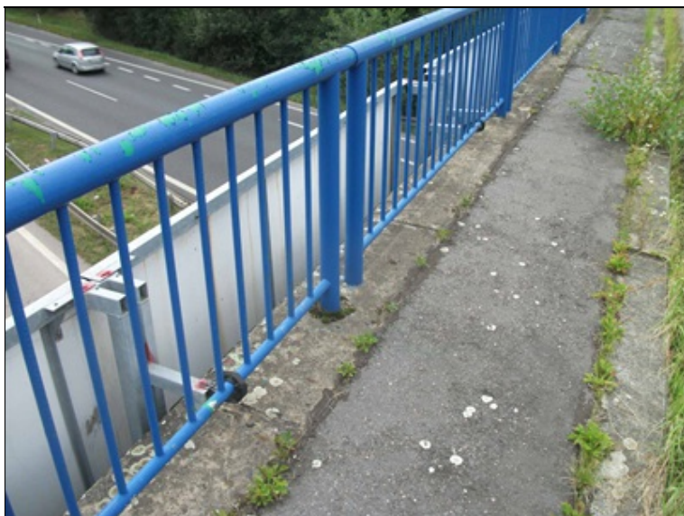
pravá strana mostu, olupování vchní vrstvy PKO
