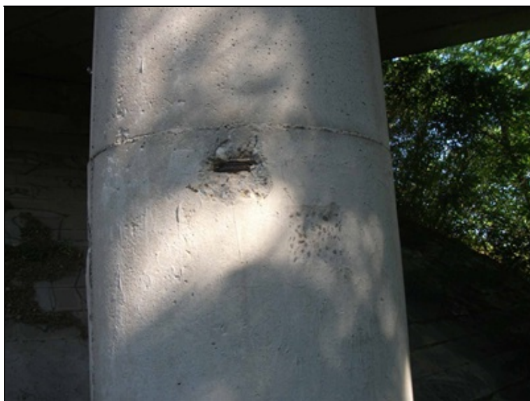
pilíř P2, odloupený povrch betonu, korodující výztuž
