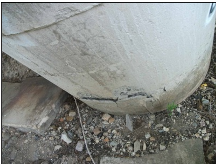
pilíř P2, separovaný beton v patě sloupu
