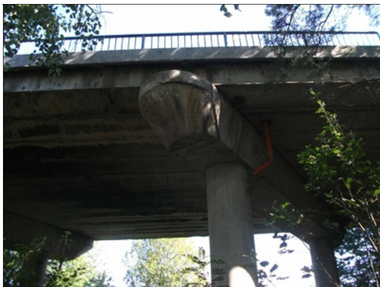
pravé čelo pilíře P3, odhalená korodující výztuž
