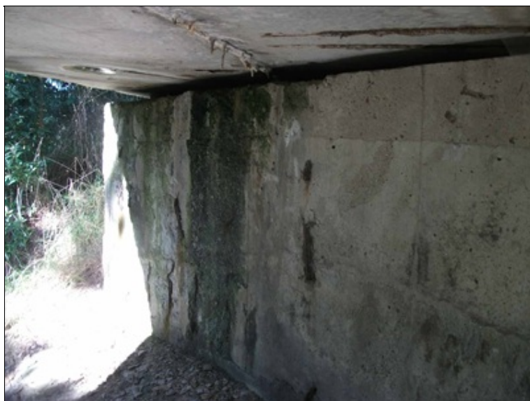
opěra OP1 a podhled NK, vlhkost v okolí otvoru v nosníku, stopy protékání NK, odhalená korodující výztuž
