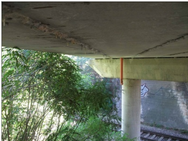
pole 1 vlevo, protékání krajní spáry, chybějící svod odvodňovače
