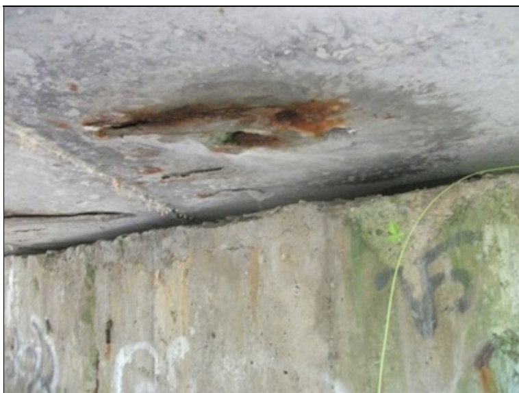
podhled NK u opěry OP5, stopy po protékání na spodku nosníku, odhalená korodující výztuž
