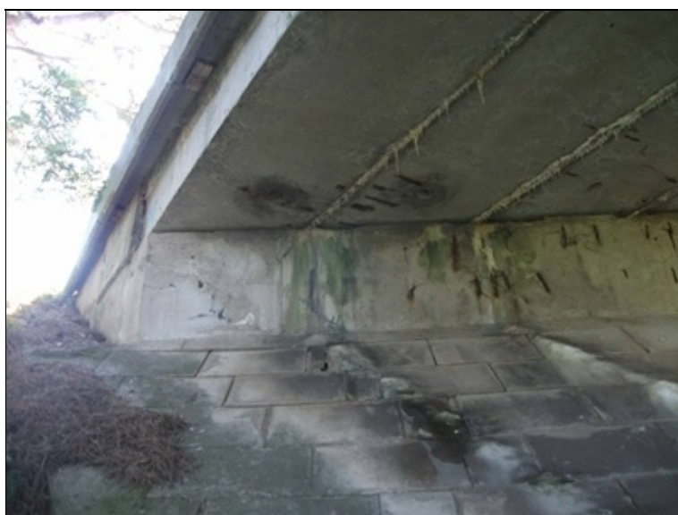
pole 3, protékající spáry NK, odhalená korodující výztuž opěry OP4 a NK
