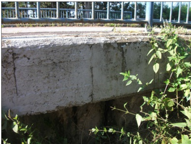
levá strana, degradace betonu říms
