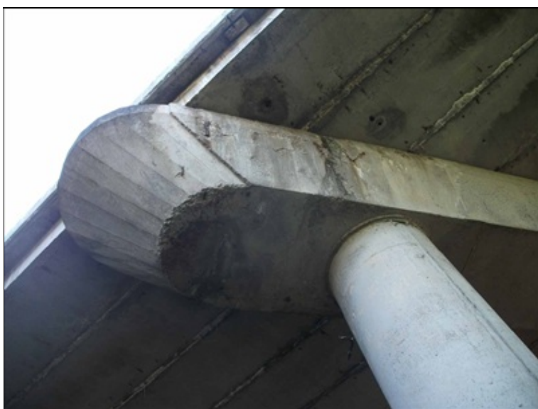
pilíř P3, protékající spáry NK, vlhkost kolem otvorů v nosnících, degradace betonu stativa a koroze odhalené výztuže
