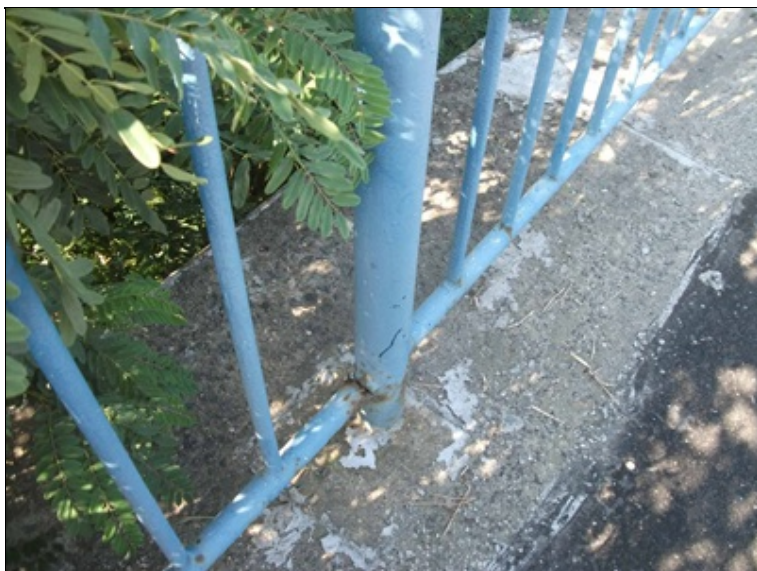
levá strana, koroze zábradlí, lokálně přerezlý profil
