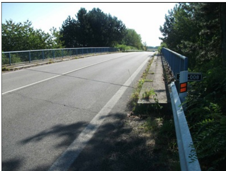
pohled na most ve směru staničení, příčná trhlina ve vozovce před mostem
