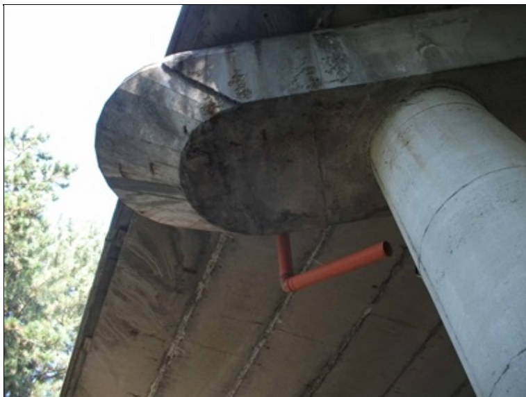
pilíř P2, čelo stativa, odhalená korodující výztuž, torzo svodu odvodňovače
