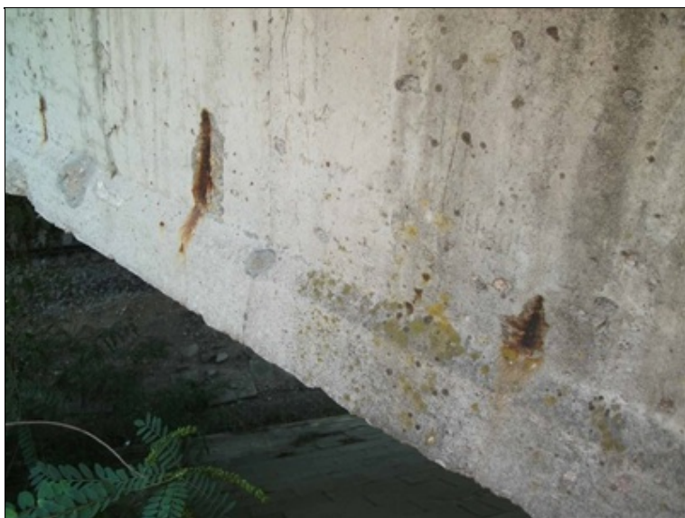
levá strana, prokreslená korodující výztuž na boku nosníku
