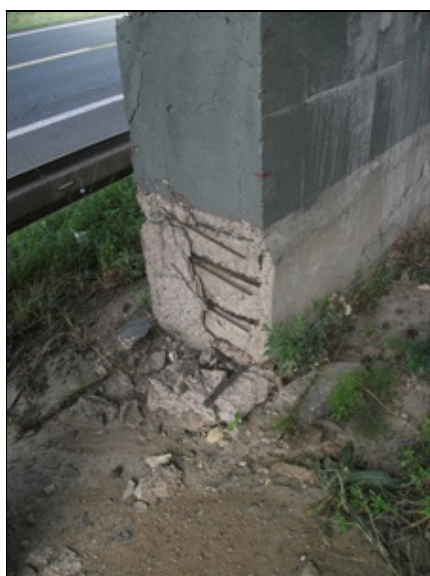
pata P2, silná degradace betonu i výztuže
