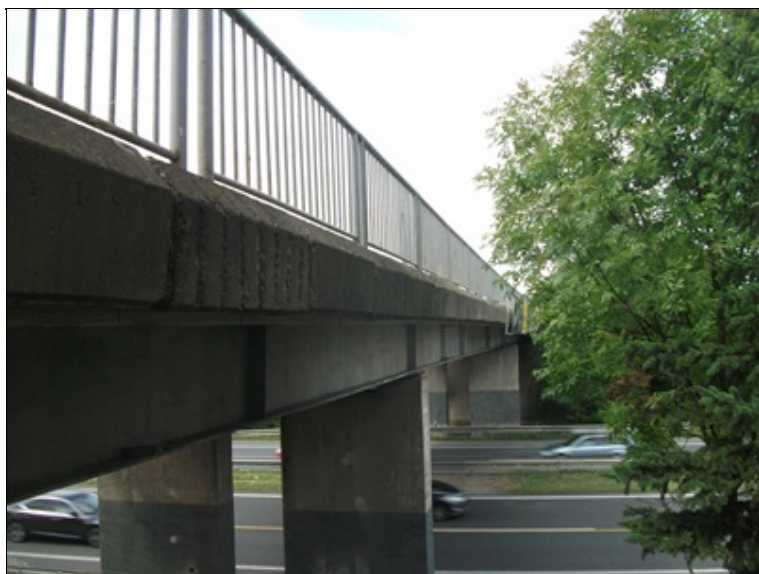
Pilíř P2, degradace betonu, odpadávání krycí vrstvy, koroze obnažené výztuže
