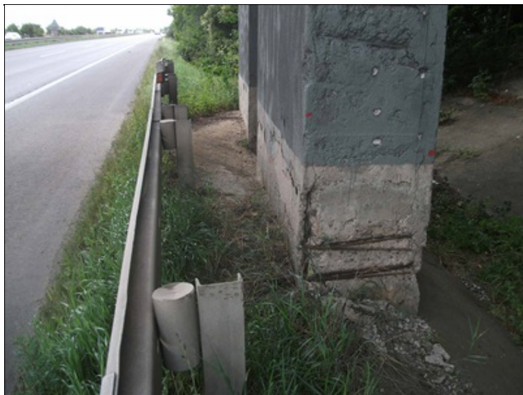
pata pilíře P3, degradace a odpadávání betonu, koroze obnažené výztuže
