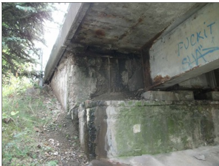
OP1 pravý bok, silná degradace betonu vlivem zatékání mostními závěry
