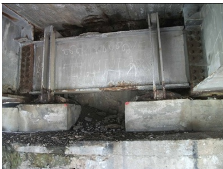
OP1, degradace betonu vlivem zatékání mostními závěry
