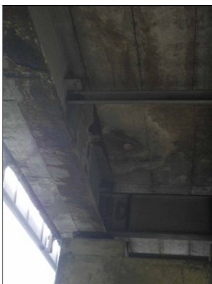
chybějící svod za P3, poruchy PKO ocelové konstrukce
