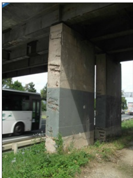
Pilíř P2, degradace betonu, odpadávání krycí vrstvy, koroze obnažené výztuže
