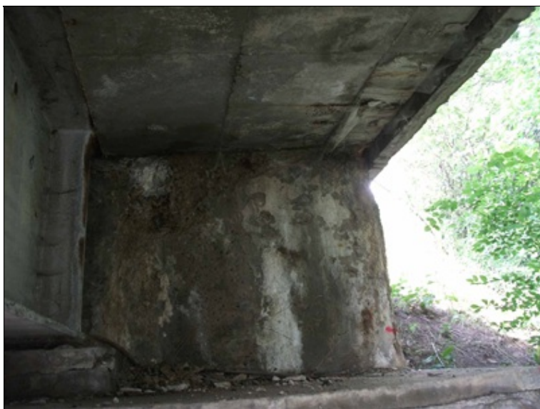
chybějící svod za P3, poruchy PKO ocelové konstrukce
