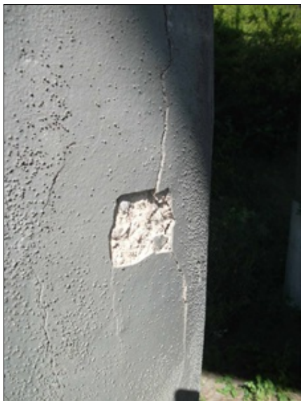
pilíř P2, odtržená sanace povrchu sloupu
