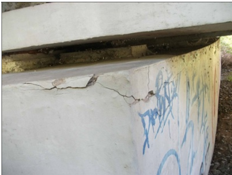
pilíř P2, trhliny v sanovaném povrchu sloupů
