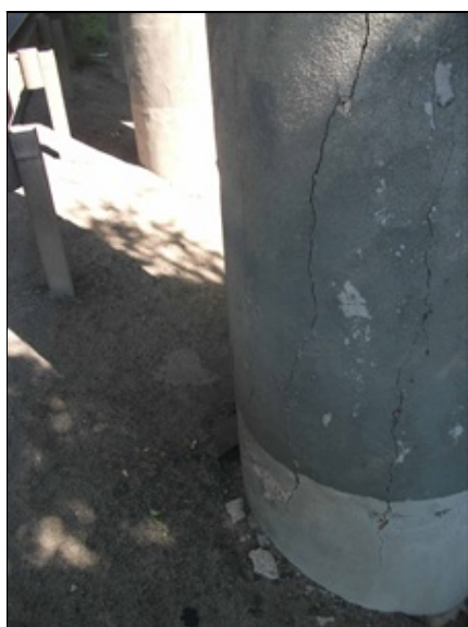
pilíř P3, trhliny v sanovaném povrchu sloupů
