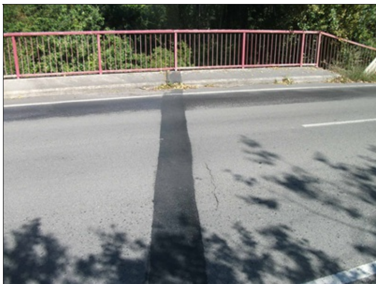
mostní závěr nad opěrou OP4, trhlina v krytu vozovky
