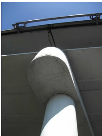
pilíř P2, trhliny v sanaci povrchu stativa
