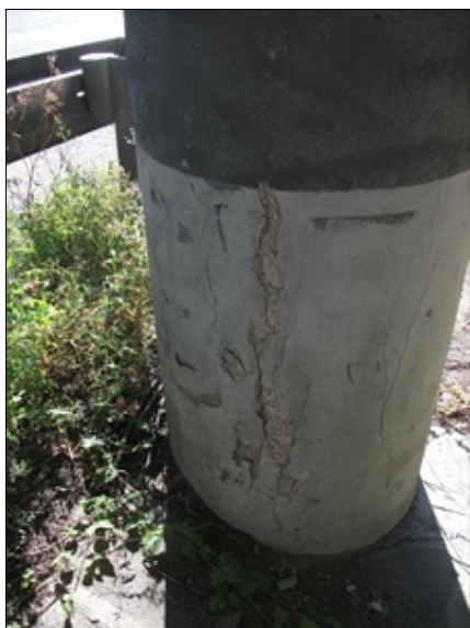
pilíř P2, trhliny v sanovaném povrchu sloupů
