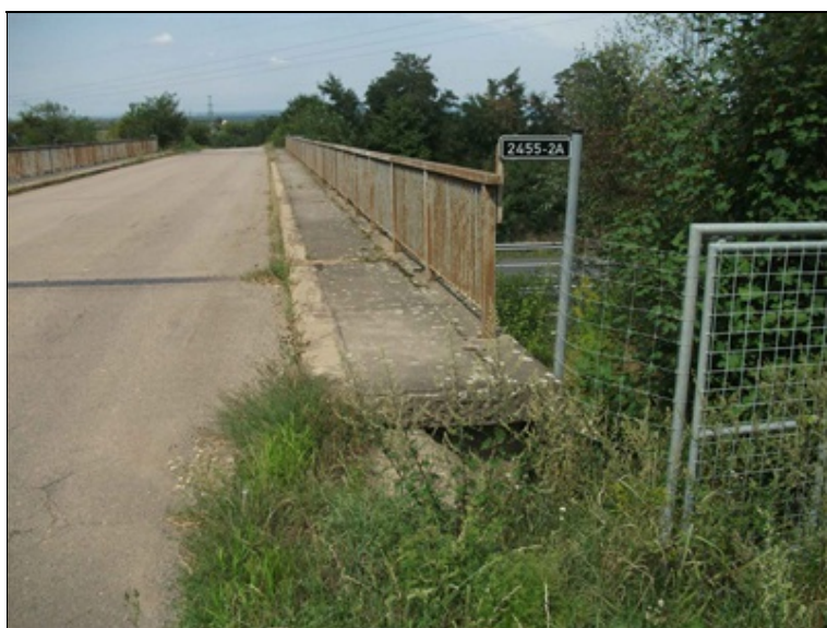
pohled proti směru staničení, odhalené čelo římsy
