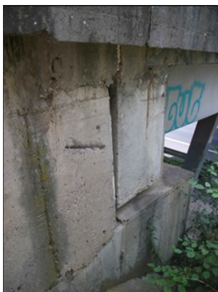
levý bok OP4, degradace betonu, odhalená korodující výztuž
