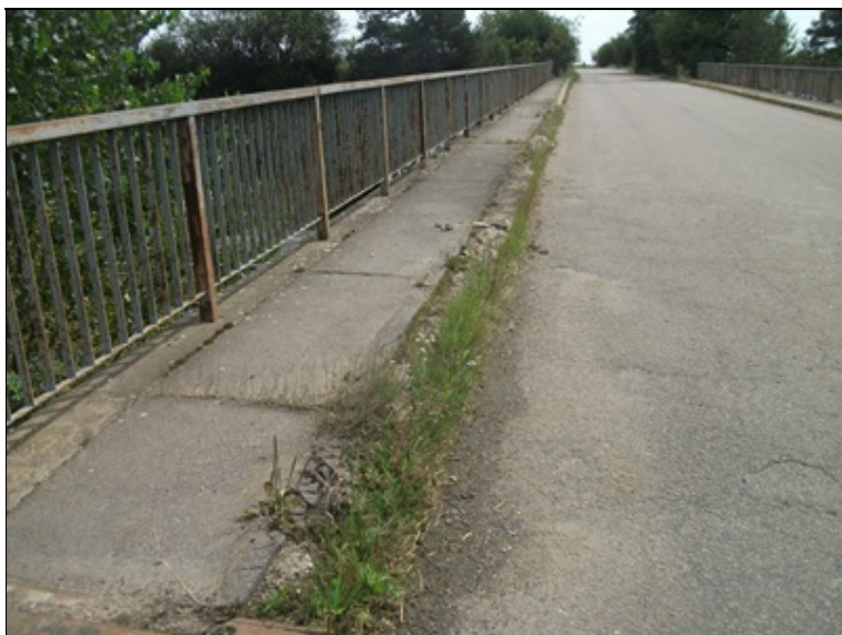
rozpadlé betonové obrubníky vlevo
