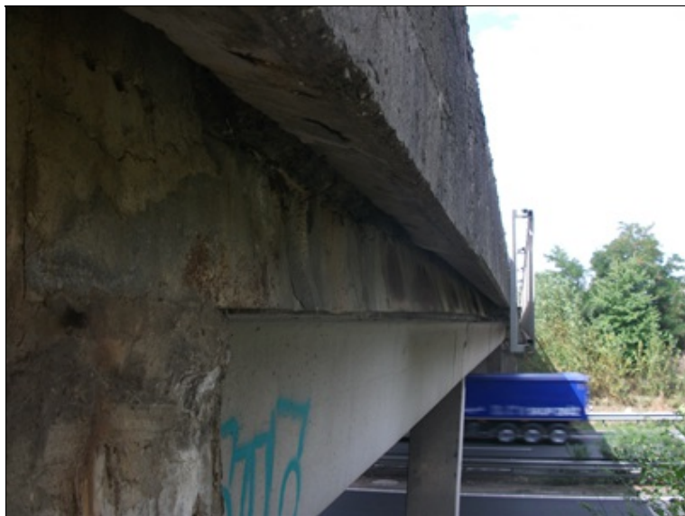
šikmé stojky, odlupování povrchové vrstvy betonu v místě výztuže, koroze obnažené výztuže
