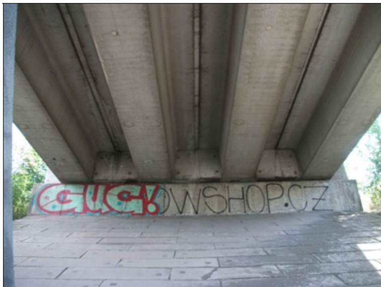
pohled na OP4, v levé části patrné protékání izolace
