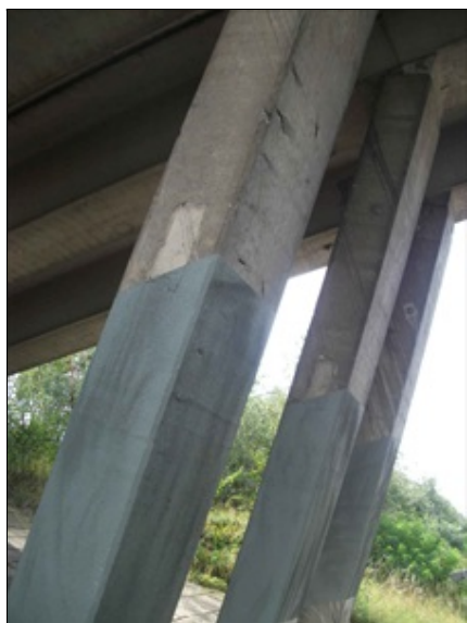
šikmé stojky, odlupování povrchové vrstvy betonu v místě výztuže, koroze obnažené výztuže
