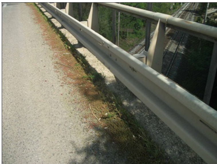
pravá strana mostu, vegetace u obrubníků, nízký nášlap, degradace betonu římsy
