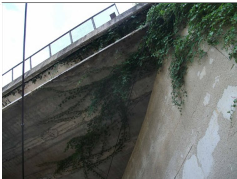
podhled NK u opěry OP1, odpadávání omítky z NK a opěry, vegetace na konstrukci mostu
