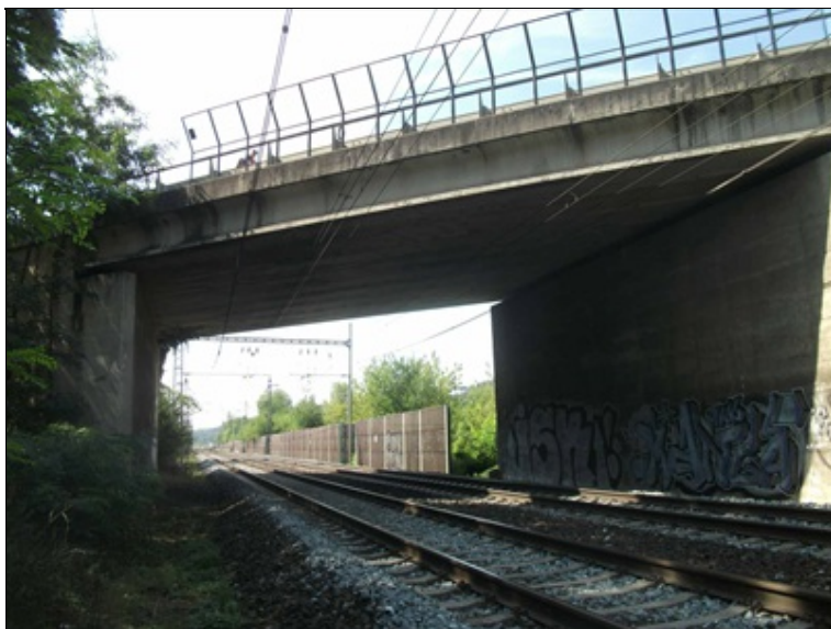
pohled na most zprava, patrná separace betonu v římsách v místě výztuže
