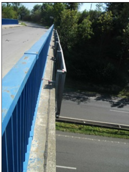
levý okraj mostu, povrchová koroze zábradlí
