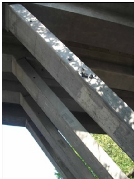
podpěra P2, šikmá stojka s datem rekonstrukce, místy odpadá krycí vrstva betonu, odhalená výztuž koroduje
