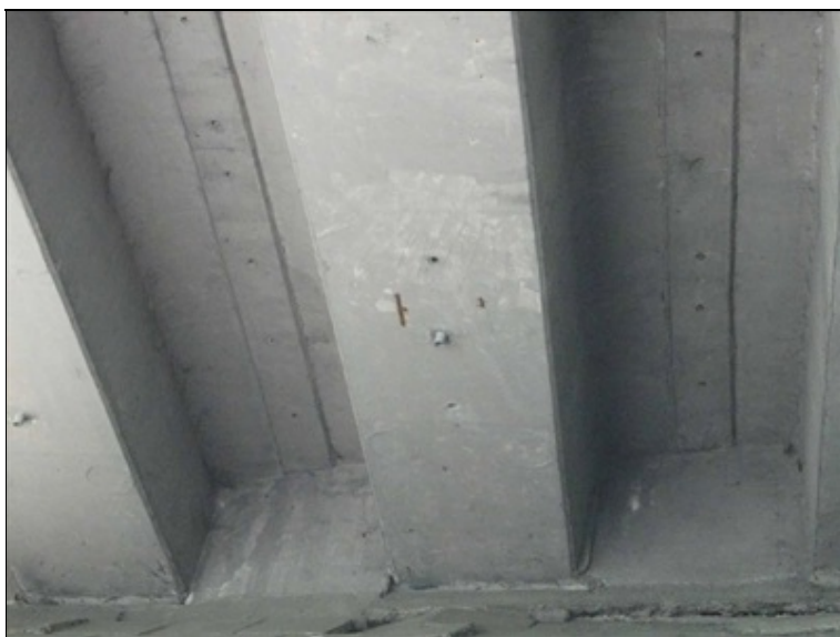
podhled NK u OP4, odpadá povrchová vrstva betonu, koroze odhalené výztuže
