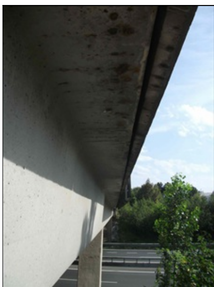
pravá strana, zatékání na nosník pod řimsou, koroze výztuže nosníku
