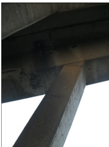
chybějící svod odvodňovače vlevo, poškození nosníku stékající vodou, průsaky kolem otvorů odvodnění dutin
