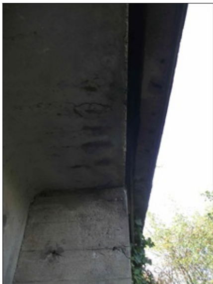
levá strana u OP1, zatékání na nosník pod římsou, koroze výztuže
