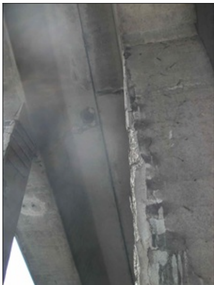
chybějící svod odvodňovače vpravo, masivní poškození stojek
