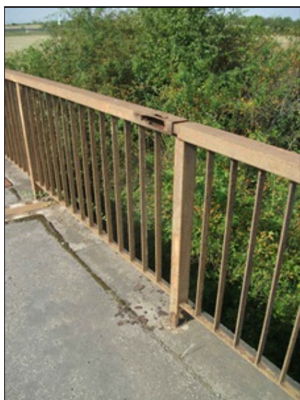
koroze zábradlí
