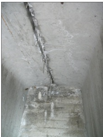
stopy zatékání do konstrukce před koncovým příčnickem nad OP4
