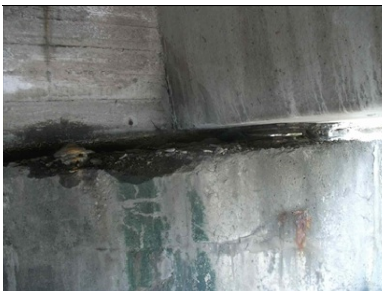
ložisko na OP4, silná koroze, zatékání na úložný práh, degradace betonu
