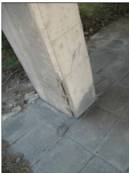
šikmá stojka P3, odpadávání krycí vrstvy betonu, korozí výztuže
