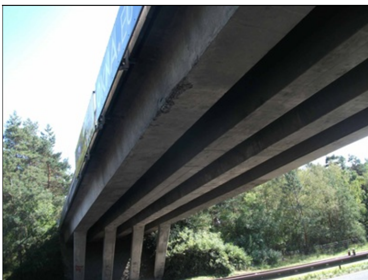
podhled středního pole zleva, poškození hrany nosníku, směr Praha
