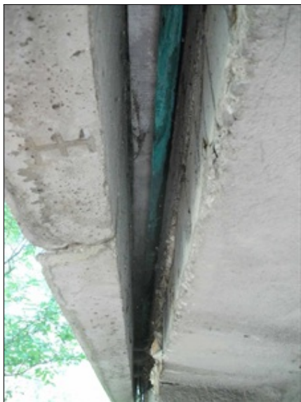
korodující okapnice pod řimsou
