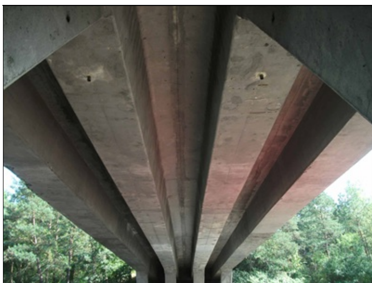
podhled NK ve středním poli, lokální koroze odhalené výztuže, stopy průsaků v okolí odvodňovacích otvorů
