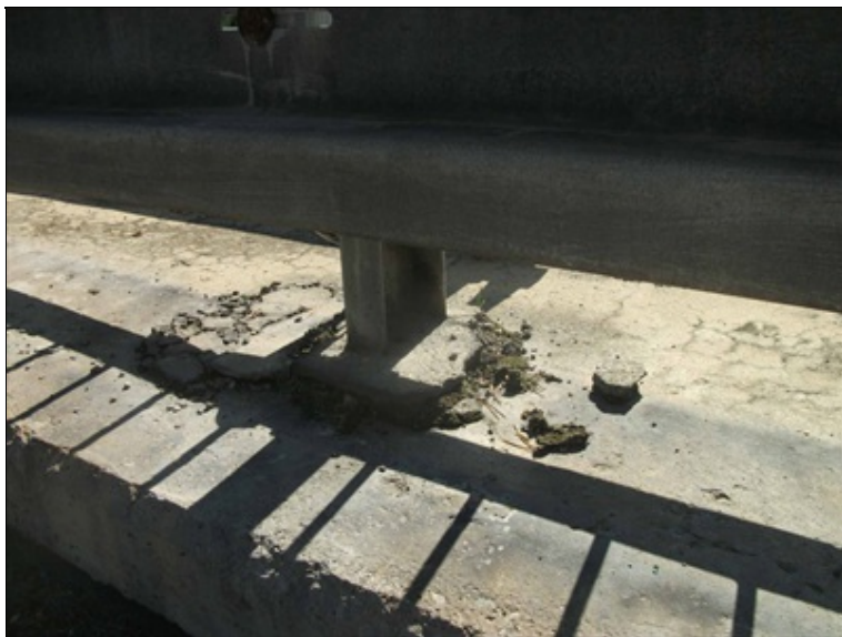
poruchy kotvení sloupku zábradelního svodidla (vpravo)
