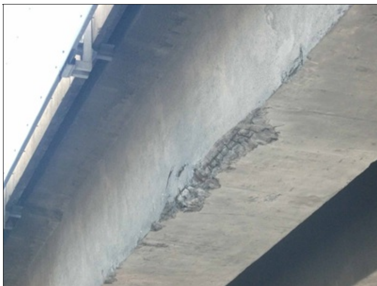
šikmá stojka P2, odpadávání krycí vrstvy betonu, koroze výztuže
