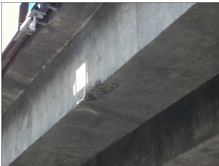
poškození dolní hrany nosníku, směr Turnov
