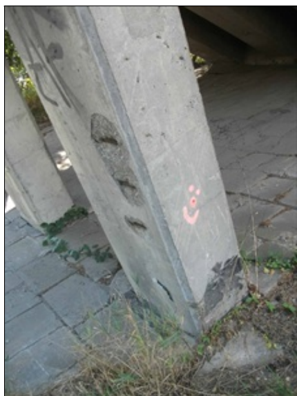
šikmá stojka P2, odpadávání krycí vrstvy betonu, koroze výztuže
