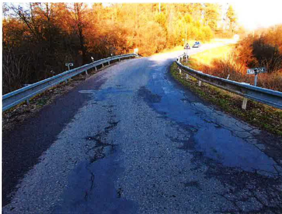
pohled na most ev.č. 125-008
