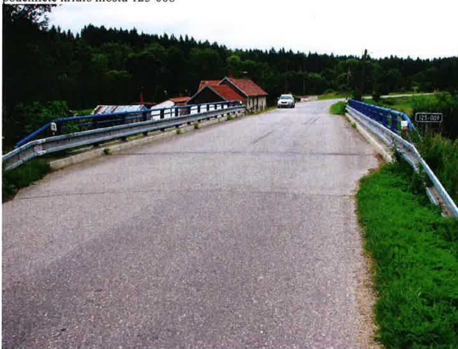
pohled na most ev.č. 125-009
