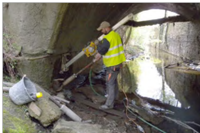
foto 8: Hloubení šikmého vrtu Š-1 pro ověření založení mostu
