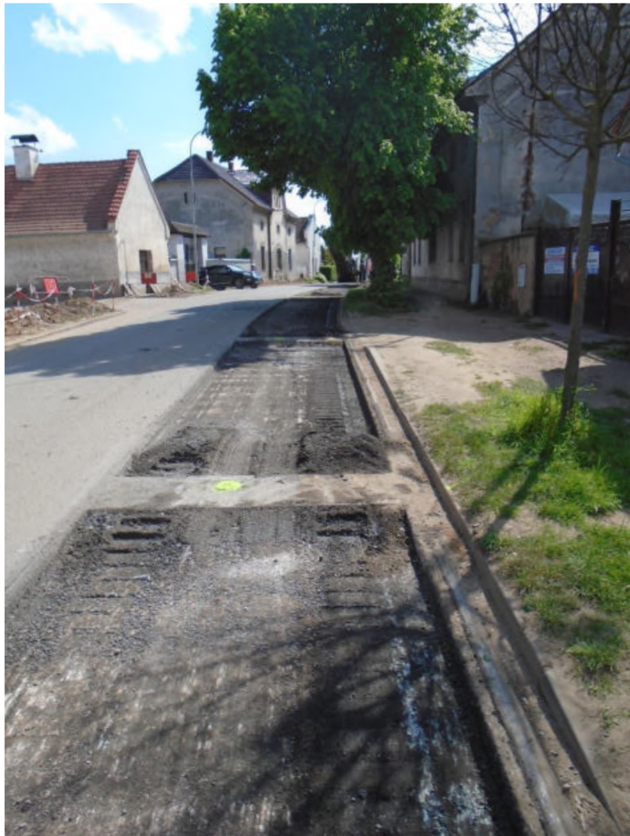
Příloha č. 2 – Fotodokumentace stavu stávajících podkladních vrstev ze dne 15. 05. 2023
