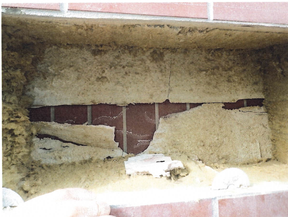
Obr. 3.11: Sonda 4 v řezu, částečná absence lepicí hmoty na podkladu, samovolné odpadávání lepicí hmoty od podkladu
