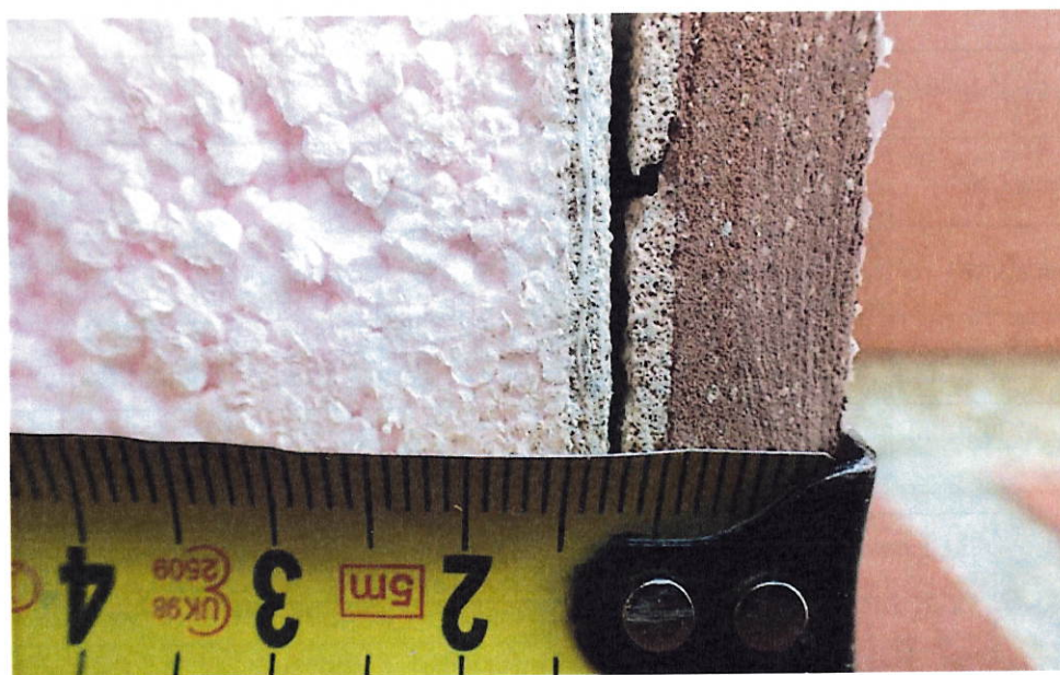
Obr. 10: Místo porušení vzorku č. 12 na rozhraní základní vrstvy a lepidla
