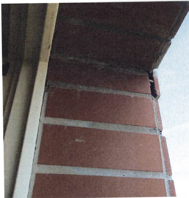
Obr.1.1: Severní fasáda, 4. NP, uvolnění obkladového pásku v blízkosti styku ostění a nadpraží v místě vertikální dilatace
