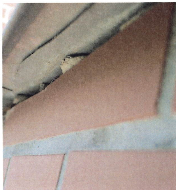
Obr.1.12: Jižní fasáda v místě napojení krycího oplechování atiky, dutina na styku s oplechováním
