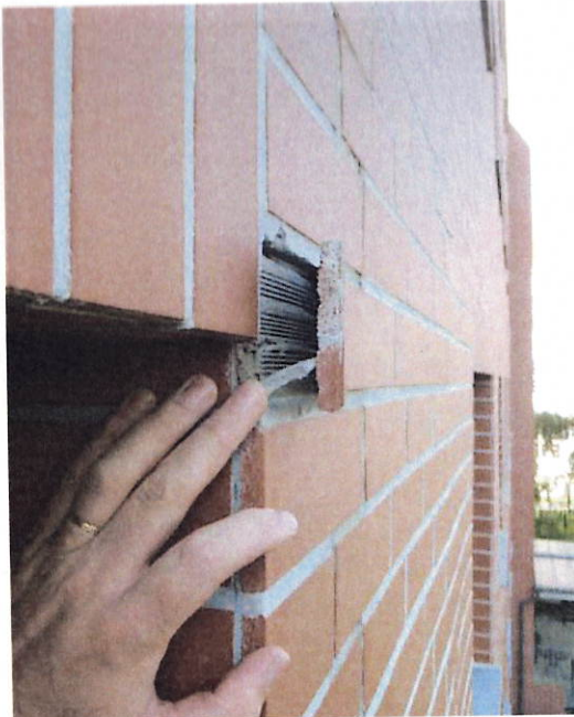
Obr.1.1: Severní fasáda, 4. NP, uvolnění obkladového pásku v blízkosti styku ostění a nadpraží v místě vertikální dilatace
