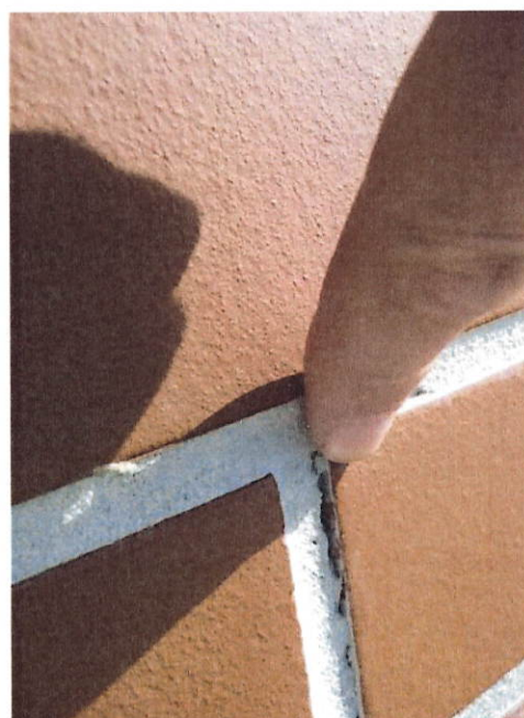
Obr.1.14: Jižní fasáda, příklad trhliny ve spárování keramického obkladu
