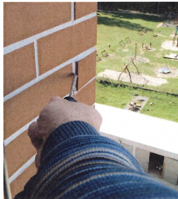
Obr.1.8: Severní fasáda, 5. NP, samovolné uvolnění obkladové dlaždice
