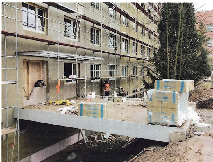
Obr. 4: Pohled na rozpracované zateplení se skládkou tepelného izolantu
