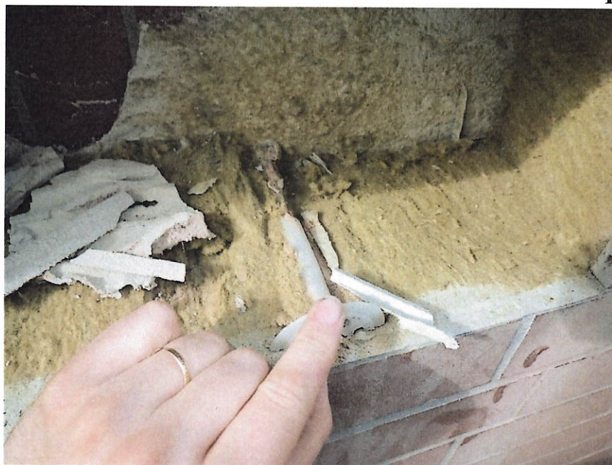
Obr. 3.12: Sonda 4, umístění hmoždinky a kotvícího trnu
