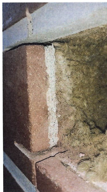
Obr. 3.15: Sonda 5, detail lepení dlaždice v řezu, lepidlo nanášené pouze na podklad
