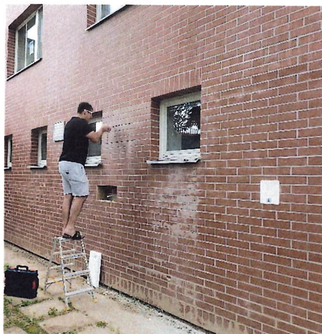
Obr.1.25: Severní fasáda v místě dispozičního úskoku fasád, 5. NP, výluhy spárovací hmoty, souvislá trhлина na styku fasád
