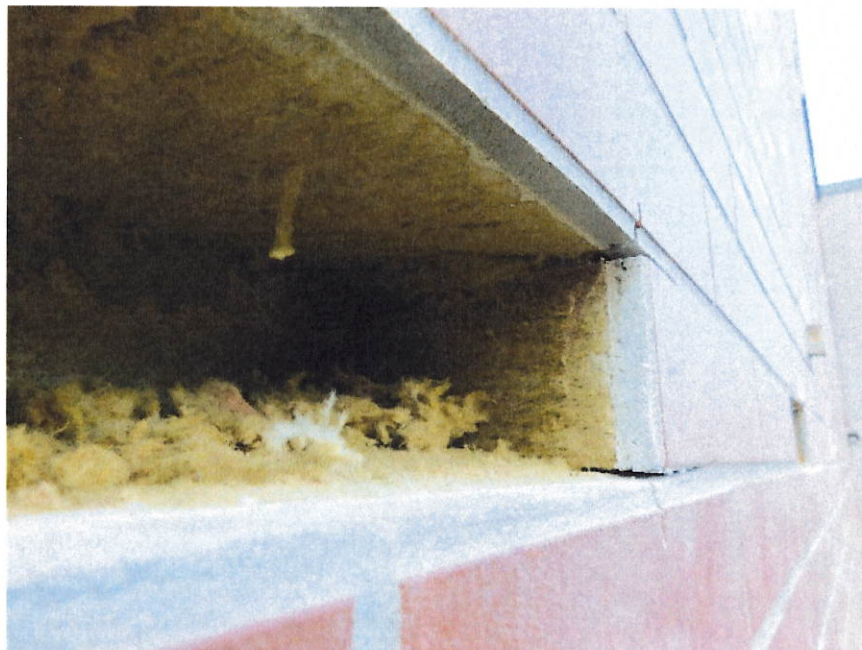
Obr. 3.7: Sonda 1 v řezu – suchý stav při povrchovém měření
