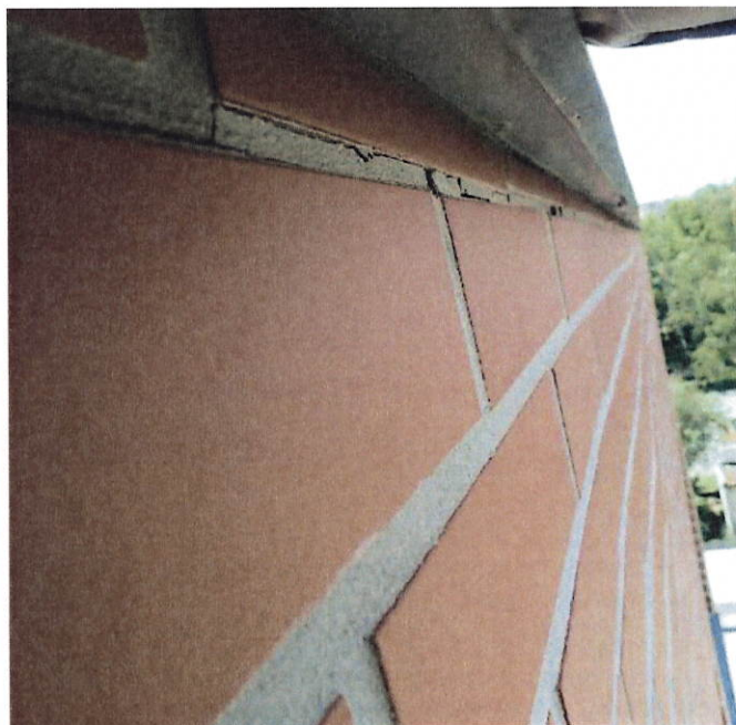
Obr.1.14: Jižní fasáda, příklad trhliny ve spárování keramického obkladu
