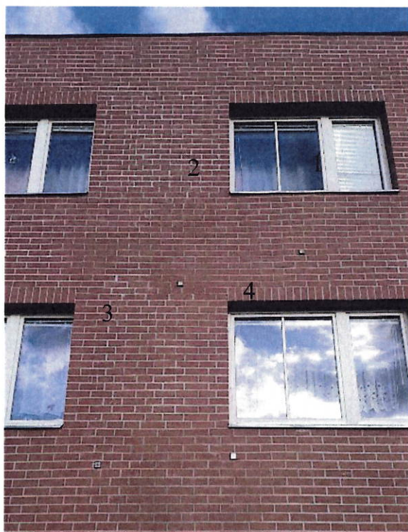
Obr. 2.2: Jihozápadní fasáda, oblast 1, místa odtrhových zkoušek 1 až 4
