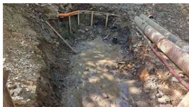
Základová spára opěry OP2 – směr Rybníky
