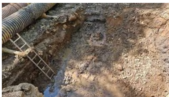
Základová spára opěry OP1 – směr Dobříš
