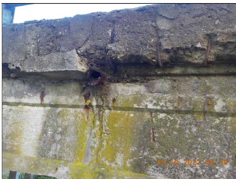
Římsa na pravé straně u opěry 4.
