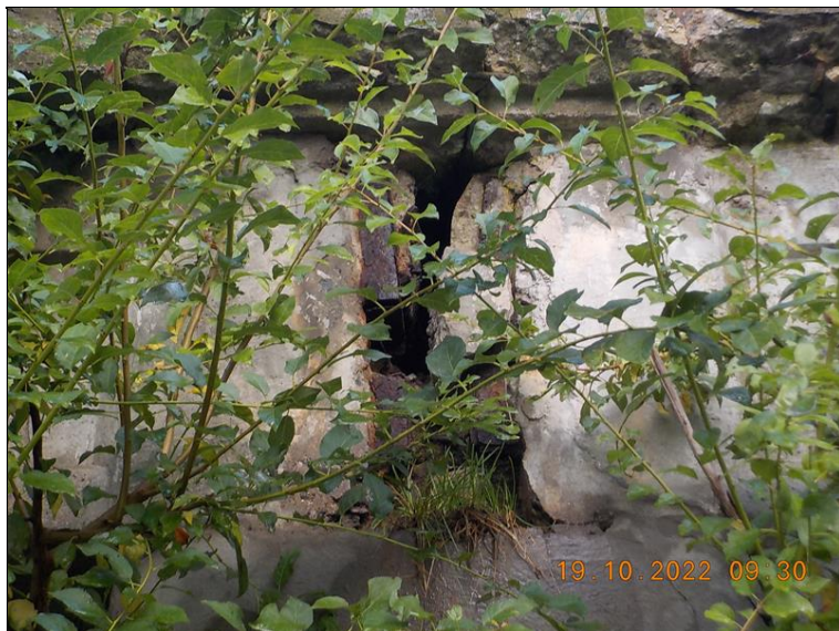
Hlava pilíře 3 zprava.
