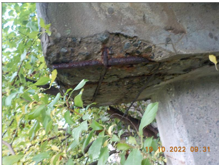
Stativo pilíře 3 vpravo.
