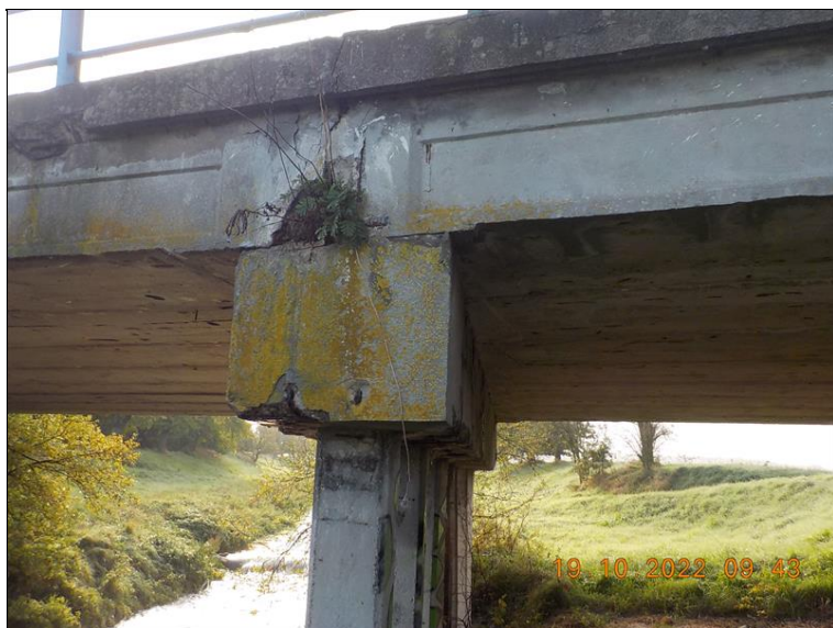
desek předpětí. Lokálně na čelech uchycená vegetace.
