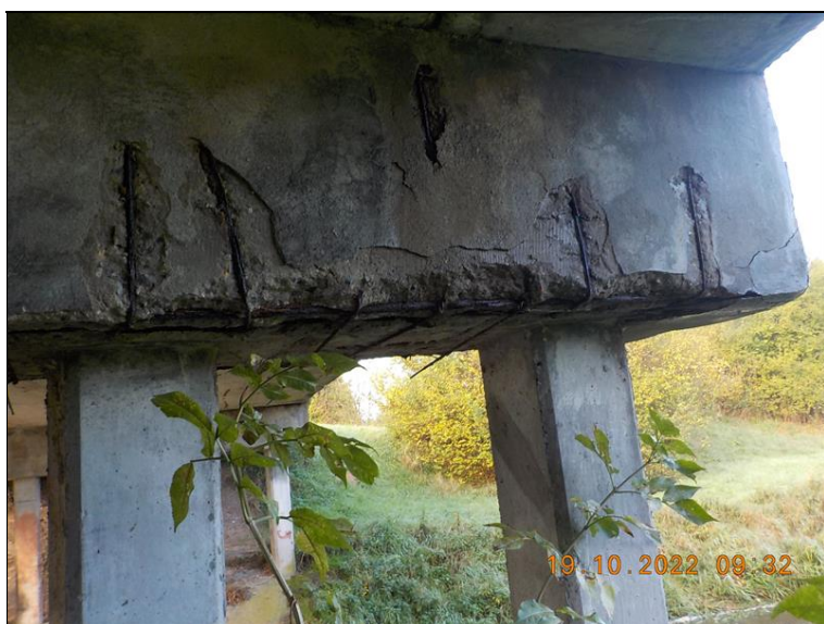
Stativo pilíře 3 vlevo.
