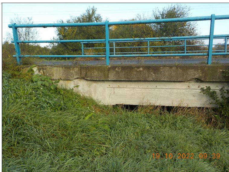
desek předpětí. Lokálně na čelech uchycená vegetace.
