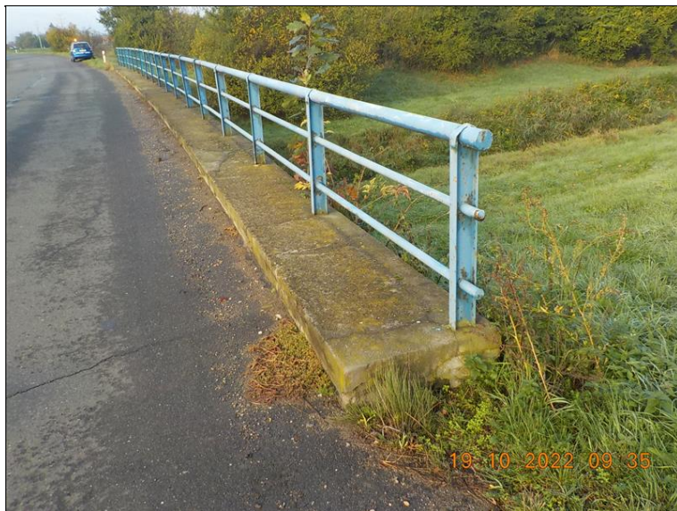
Levá strana mostu.
