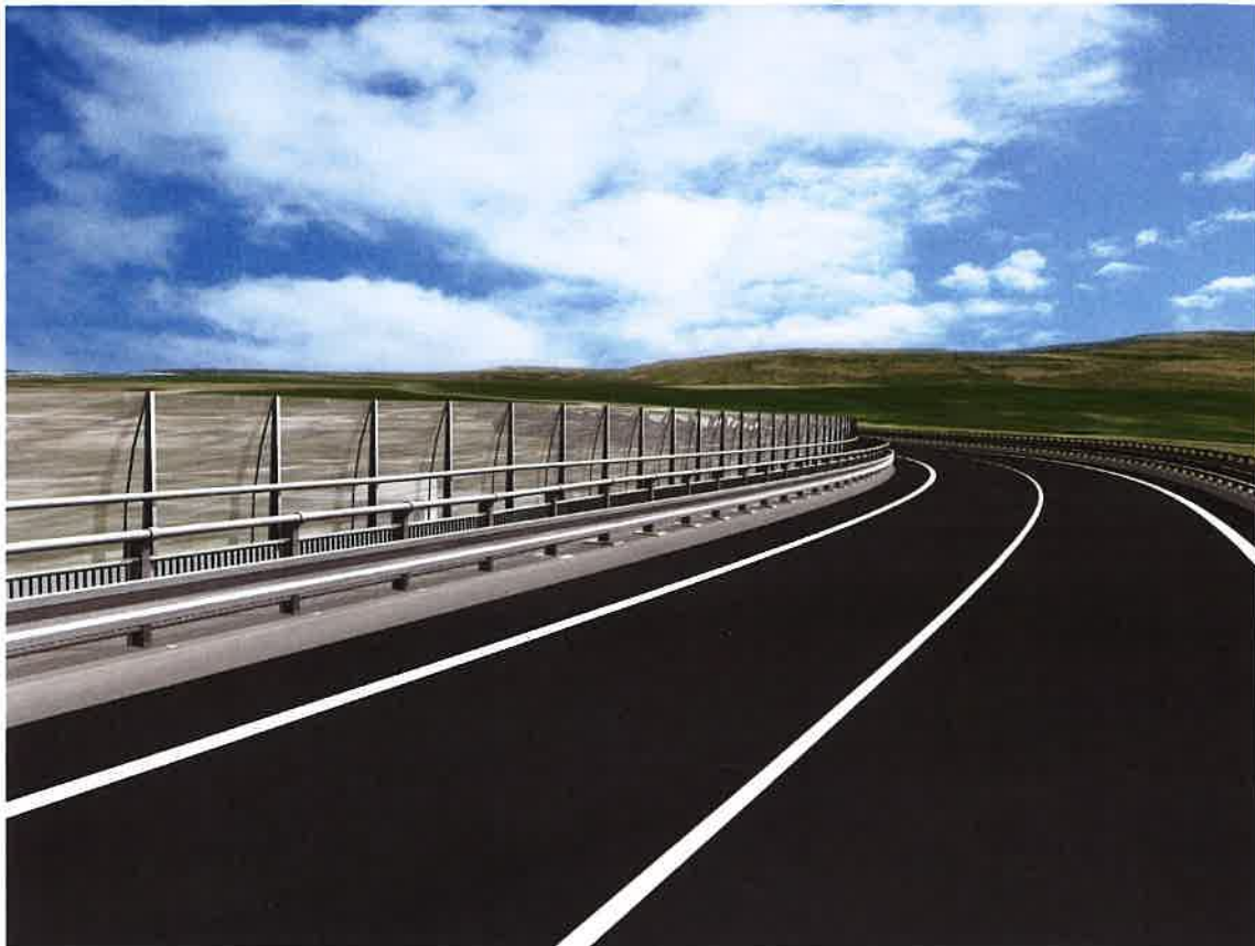
OBR.1 Pohled od jihozápadu v ose komunikace na mostě
