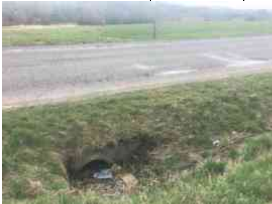
Obr. 3 Propustek 06 – pohled na vtok
