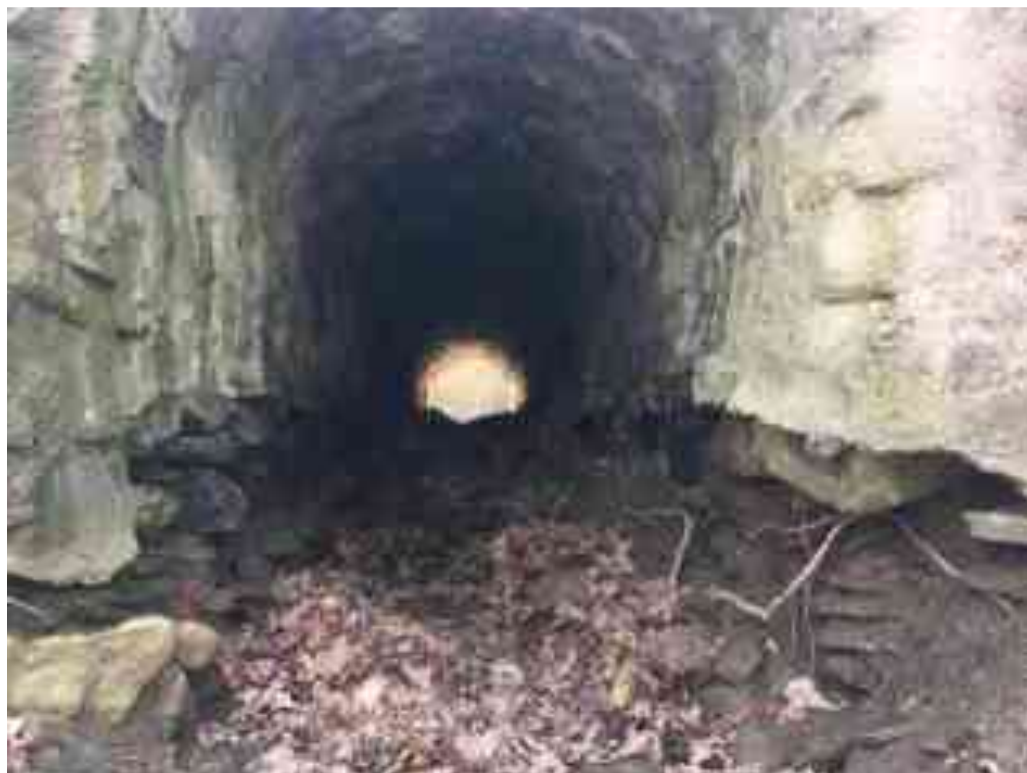
Obr. 1 Propustek 01 – pohled od severu na jih
