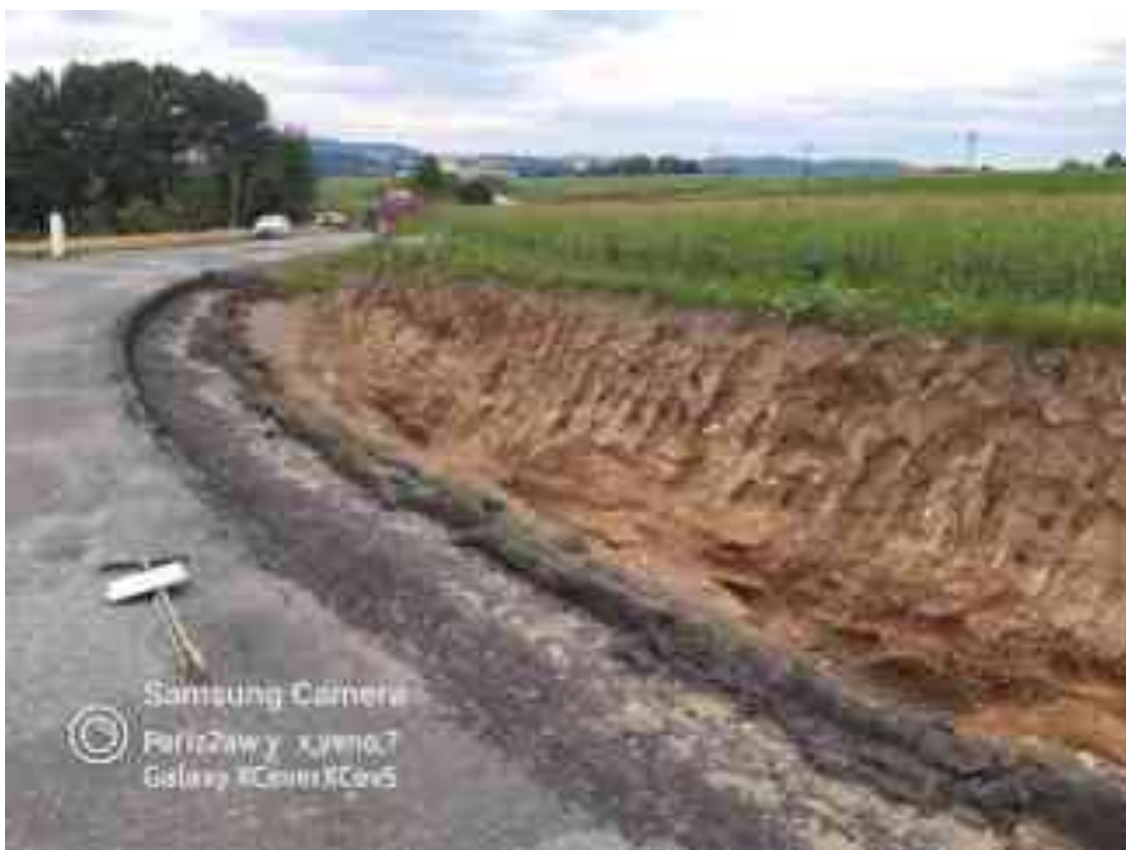
Obrázek 14 - odřez v poloskalní hornině
