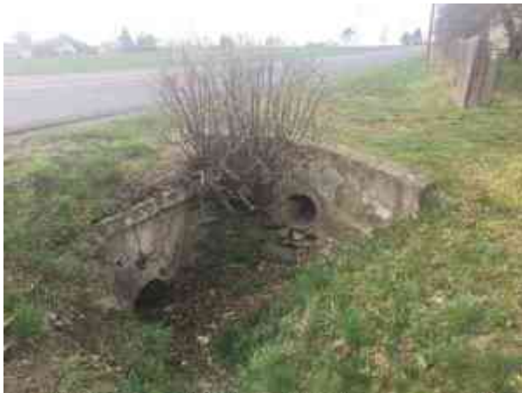
Obr. 4 Propustek 08 – pohled na vtok
