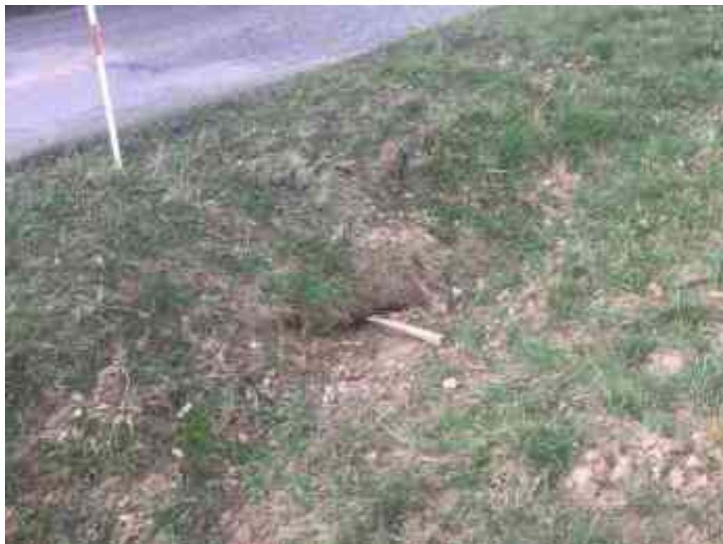
Obr.6 Propustek 10 – pohled na „vtok“
