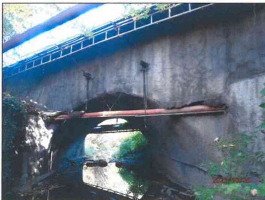
FOTO 1 – Pohled na most od JZ (Žabka, říjen 2022)
