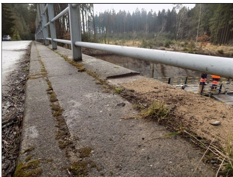
Rozpad svrchních vrstev na horním líci římsy.
