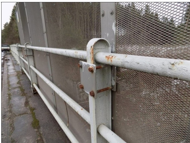
Koroze spojovacího materiálu.
