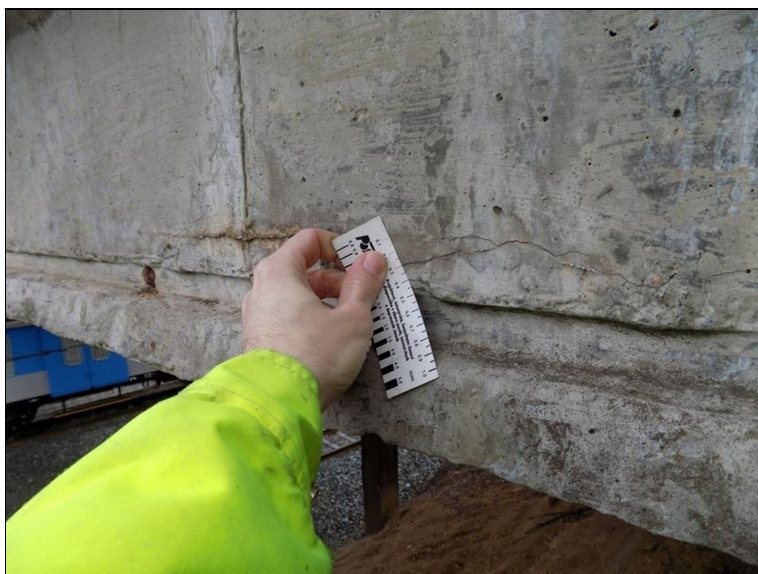
Podélná trhлина ve stěně pravého nosníku v poli 3.
