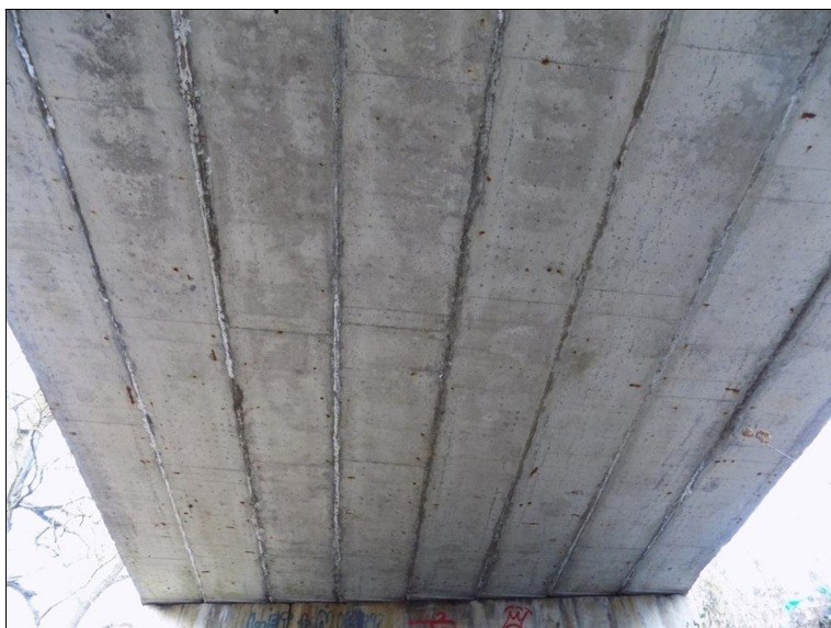
Podhled NK v poli 1, tvorba výluhů z dobetonávek mezi nosníky.
