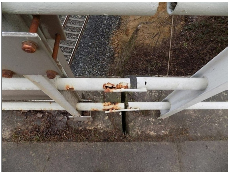
Koroze zakončení výplně zábradlí, přerušené propojení výplně.
