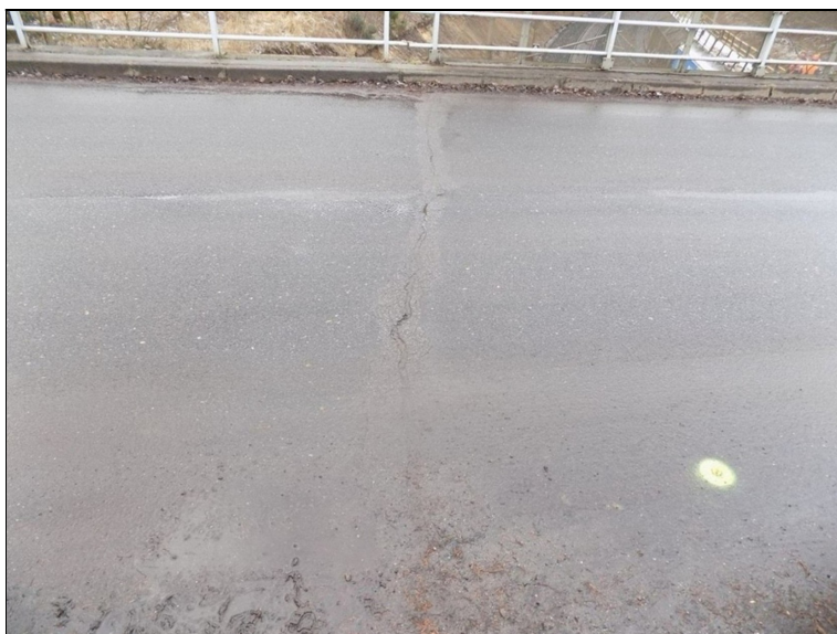
Trhliny kopírující spáru mezi nosníky, pole 2/3.
