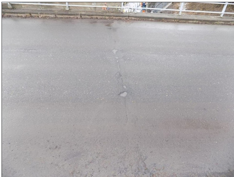
Trhliny kopírující spáru mezi nosníky, pole 1/2.
