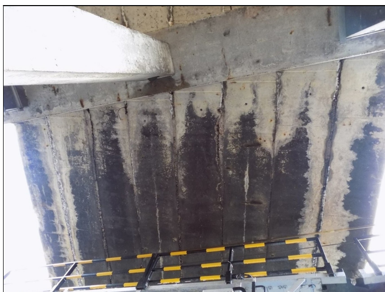
Podélné trhliny na dolním líci nosníků v poli 2 u Pi2. Poškozený pravý okraj 5. nosníku zleva.
