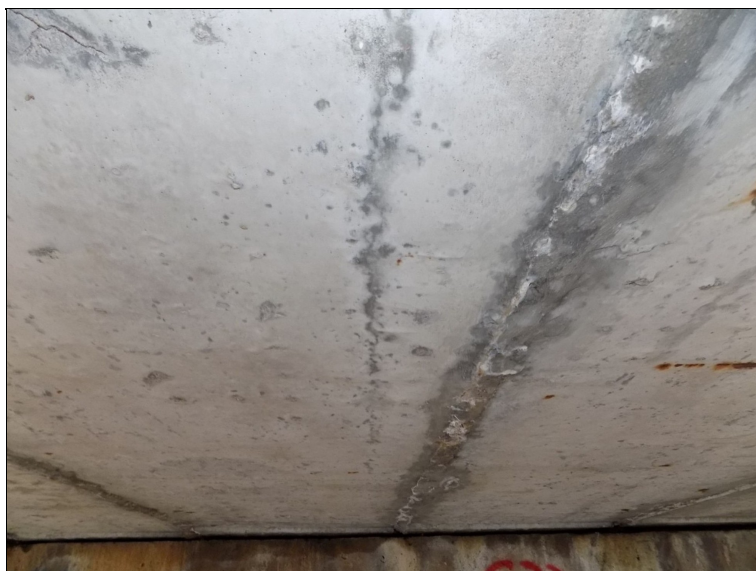
Prokreslená podélná trhlina s průsakem na dolním líci nosníku v poli 1.
