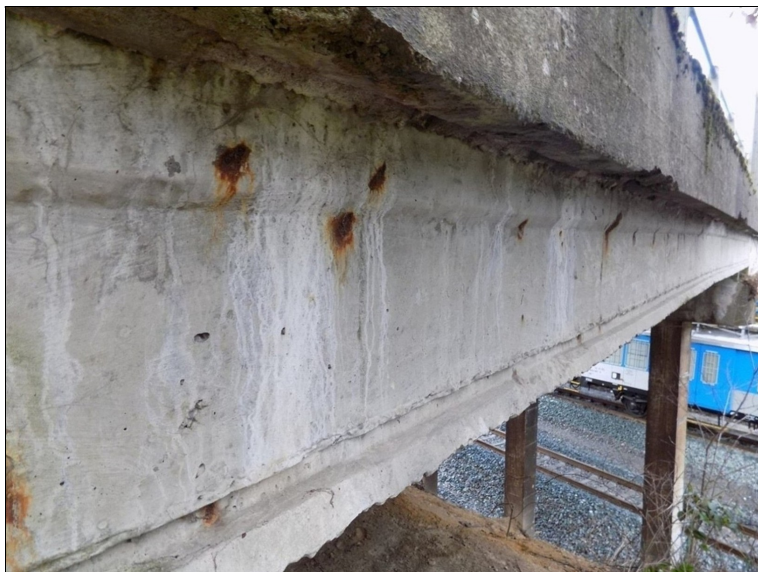
Výluhy ze spáry zpod římsy na bok NK, koroze betonářské výztuže.
