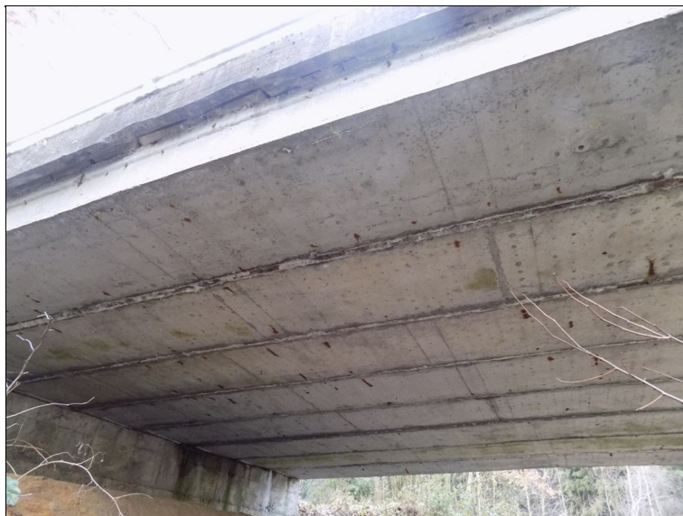
Podhled NK v poli 3, tvorba výluhů z dobetonávek mezi nosníky.
