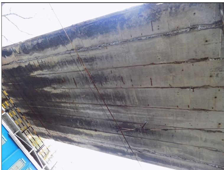
Podhled NK v poli 2, tvorba výluhů z dobetonávek mezi nosníky.
