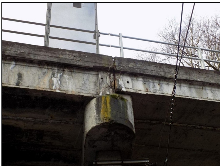
Průsaky ve spáře mezi nosníky, pole 1/2. Degradace stativa Pi2, výluhy na boku NK.
