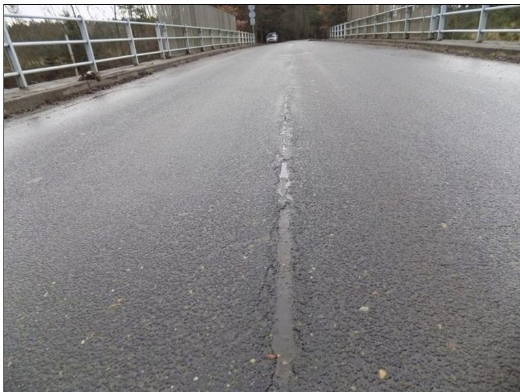
Podélná trhlinka v ose vozovky.
