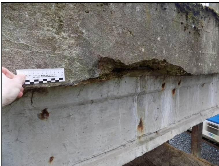
Poškozený beton římsy.
