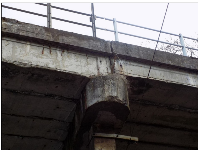
Degradace betonu dobetonávek konců nosníků pole 2/3. Silná degradace betonu stativa Pi3.
