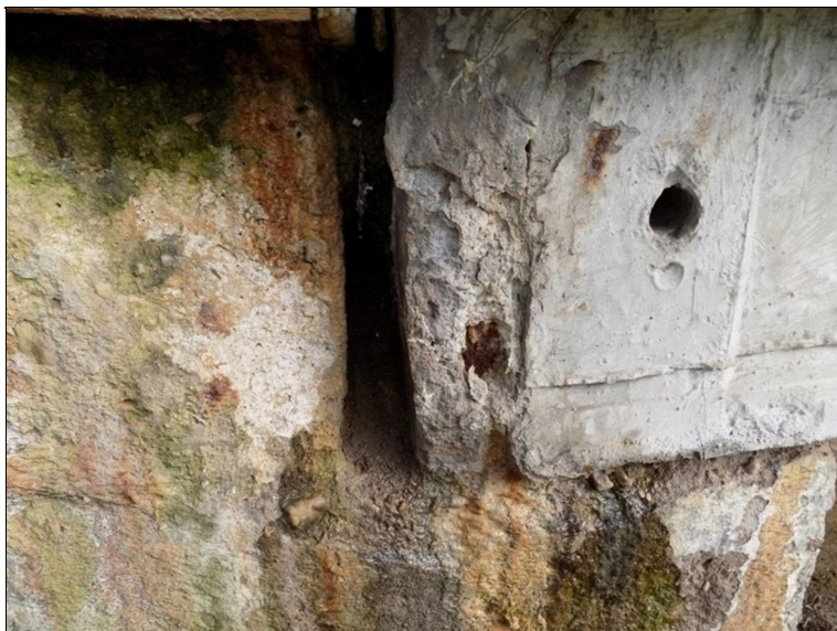
Silné průsaky v dilatační spáře, pravá strana OP1, koroze kotvy předpínací výztuže.
