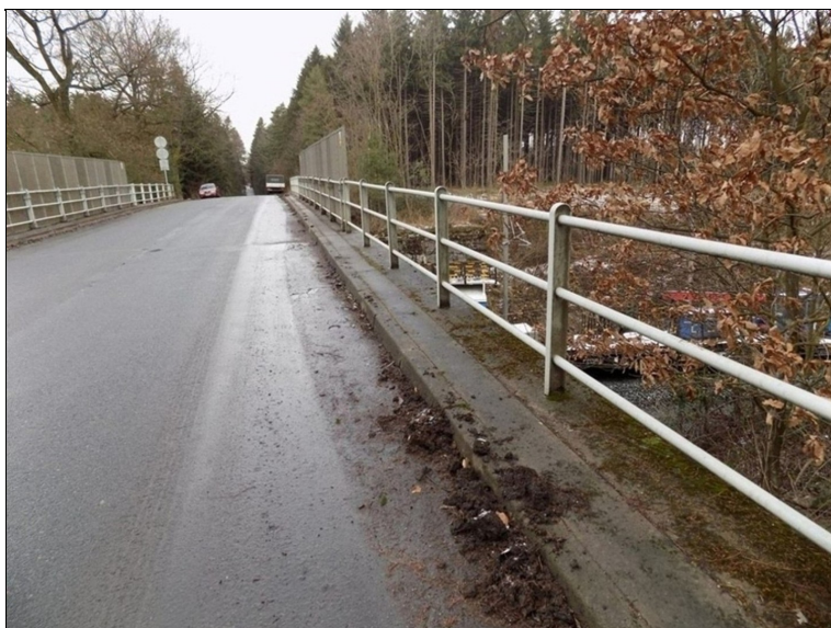
Nahromaděné nečistoty podél obrub.
