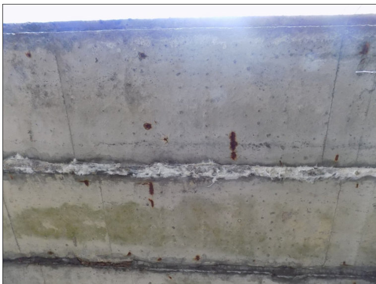
Podélná trhлина na dolním líci pravého nosníku v poli 3.
