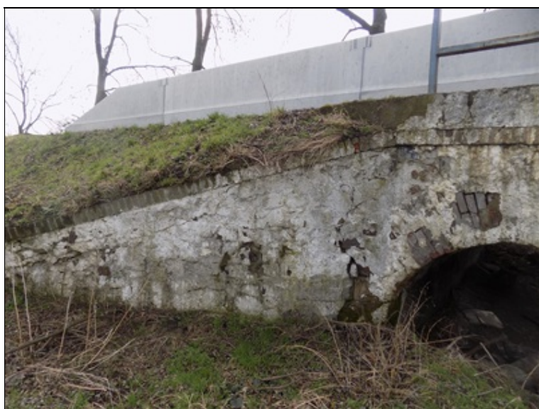
Trhlina mezi křídlem a OP4 na levé straně.
