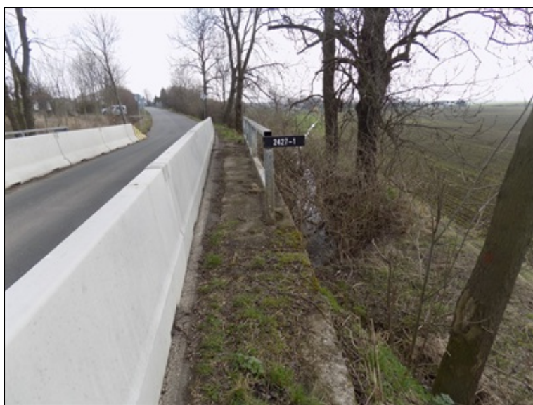
Vegetace uchycená na římse a krajnici.
