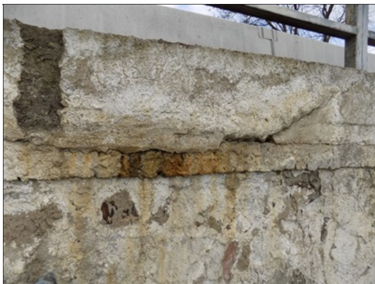
Detail degradace římsy.
