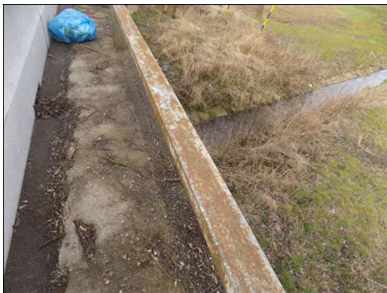
Povrchová koroze zábradlí.
