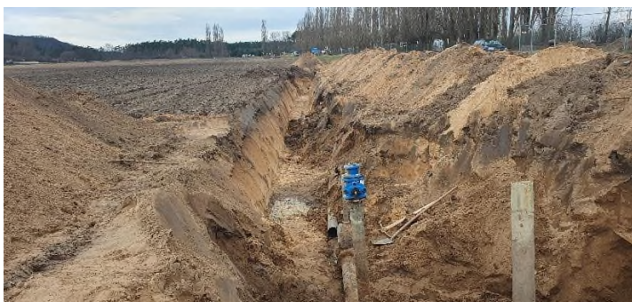
Výkop pro SO 311 v km cca 0,4 až 0,45
