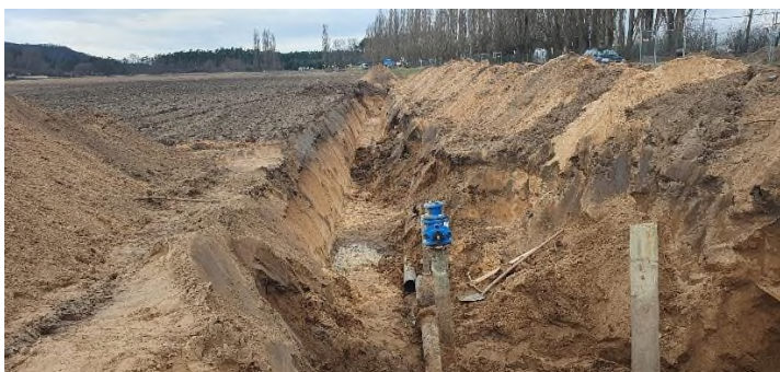
Výkop pro SO 311 v km cca 0,4 až 0,45
