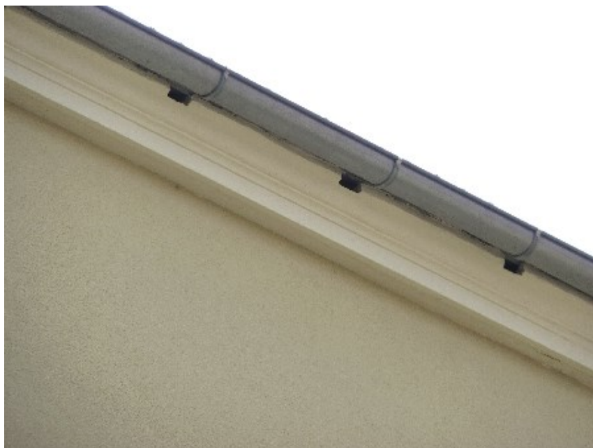
Obr 8. Příklad úpravy vletových otvorů pro rorýse na rozměry 30 (výška) x 60 mm (šířka). Upravené otvory doporučujeme rozložit ideálně tak, aby připadal vždy jeden prostup na prostor mezi dvěma krokvemi. Tento rozměr neumožňuje průnik holubům.
