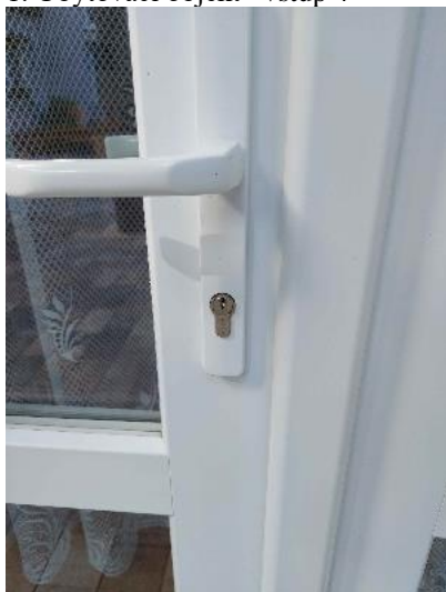
5. Ubytovací objekt –vstup 5
