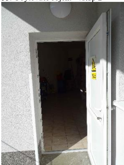
34. Ubytovací objekt – Stravování sklad 3
