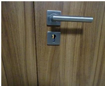
39. Ubytovací objekt — SB oddělení 4
