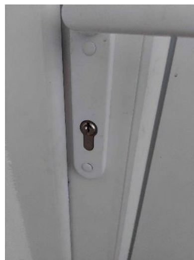
19. Ubytovací objekt – SB střecha
