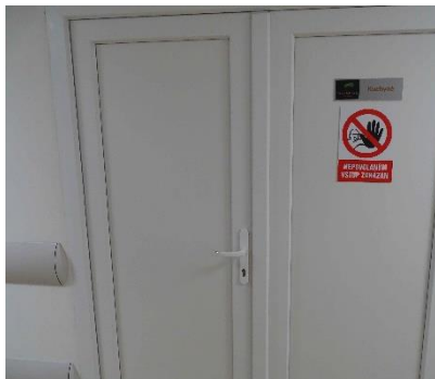
41. Ubytovací objekt – Stravování kuchyn
