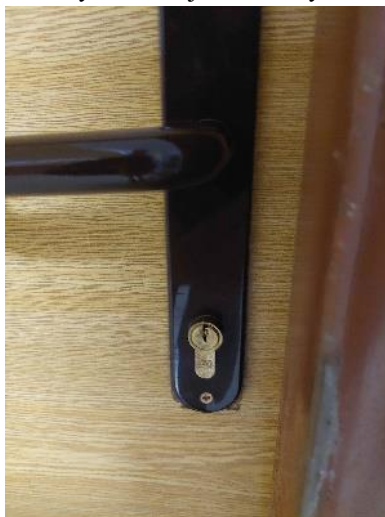
14. Ubytovací objekt – kuchyňka 2
