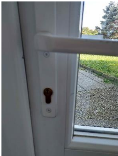
3. Ubytovací objekt –vstup 3
