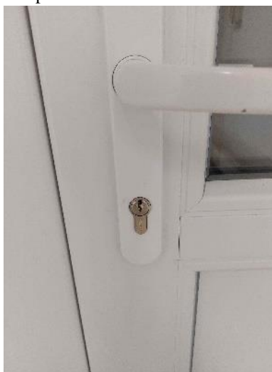
27. Ubytovací objekt – Prádelna vstup
