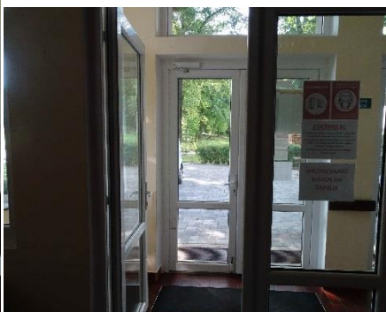
1. Ubytovací objekt –vstup 1
