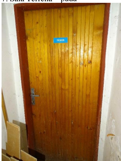
8. Sala Terrena – spodní vstup na schodiště
