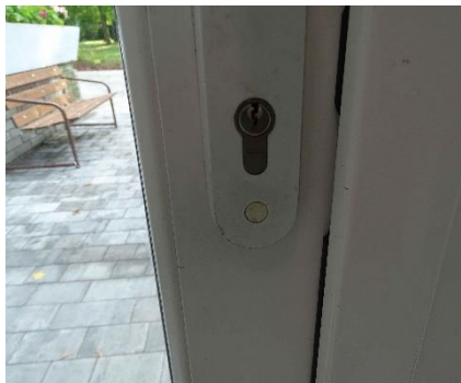
6. Ubytovací objekt –vstup 6
