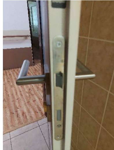
22. Ubytovací objekt – NB kuchyňka 1
