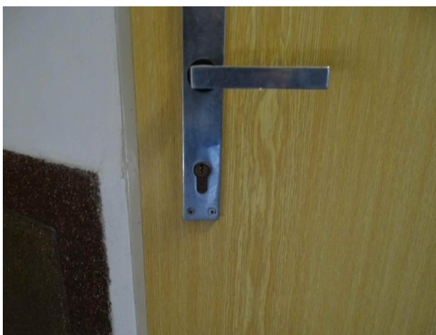
37. Zámek – schodiště mezipatro 2NP/3NP 302
