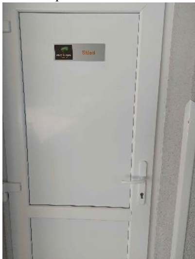
31. Ubytovací objekt – Stravování sklad 2
