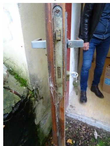
8. Sala Terrena – spodní vstup na schodiště
