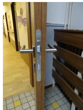
39. Ubytovací objekt — SB oddělení 4
