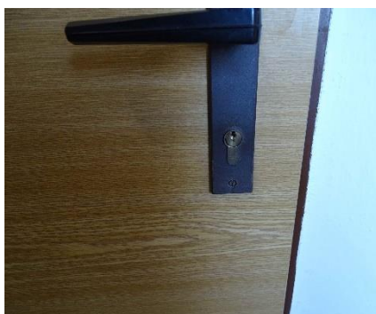
46. Ubytovací objekt – Rozvodna
