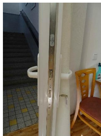
36. Ubytovací objekt – NB oddělení 5
