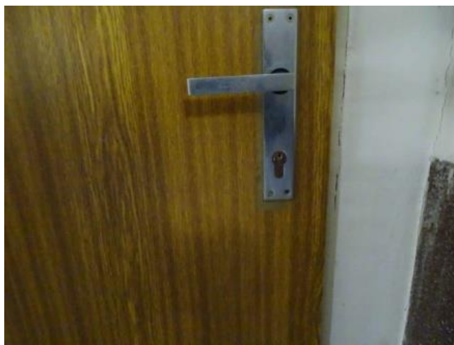
38. Zámek – schodiště mezipatro 2NP/3NP 301
