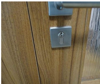
38. Ubytovací objekt – SB oddělení 5
