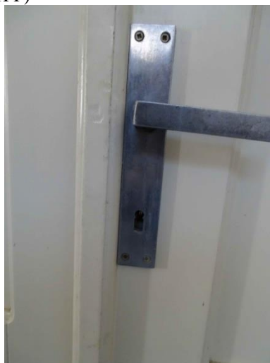
41. Zámek – schodiště VĚŽ 1NP (do 1PP)
