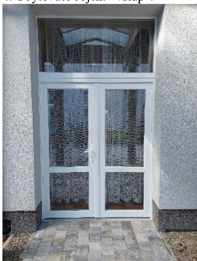
5. Ubytovací objekt –vstup 5
