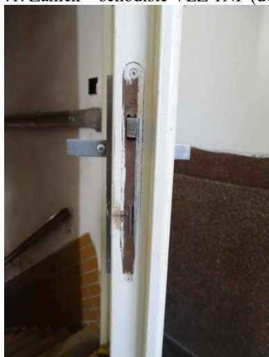
41. Zámek – schodiště VĚŽ 1NP (do 1PP)
