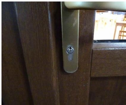
44. Ubytovací objekt – Jídelna 2
