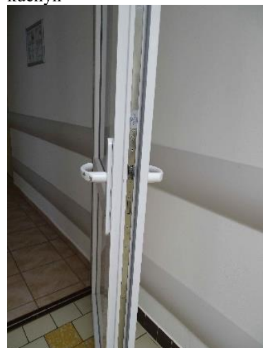
42. Ubytovací objekt – Prádelna vstup 2
