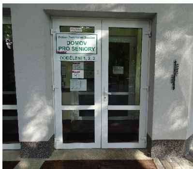
1. Ubytovací objekt –vstup 1
