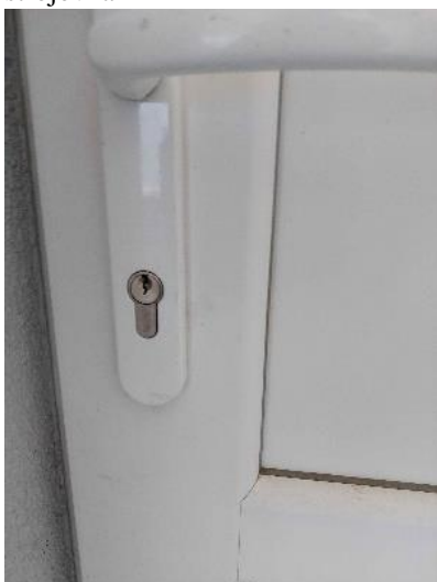
33. Ubytovací objekt –vstup 2
