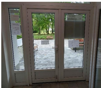
6. Ubytovací objekt –vstup 6
