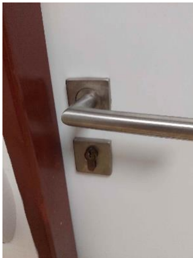
25. Ubytovací objekt – Stravování sklad 1
