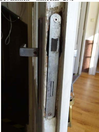
36. Zámek – schodiště VĚŽ 2NP
