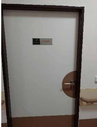
22. Ubytovací objekt – NB kuchyňka 1
