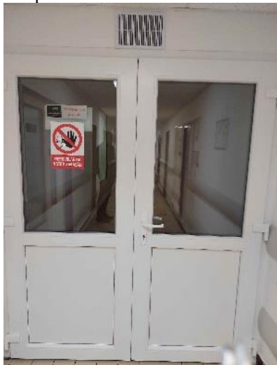
27. Ubytovací objekt – Prádelna vstup
