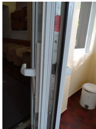
2. Ubytovací objekt –vstup 2
