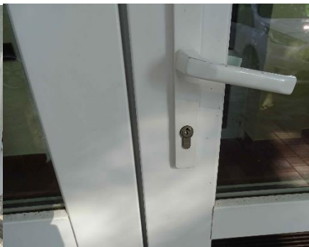
1. Ubytovací objekt –vstup 1
