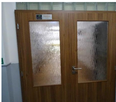
38. Ubytovací objekt – SB oddělení 5
