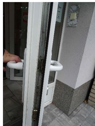
6. Ubytovací objekt –vstup 6
