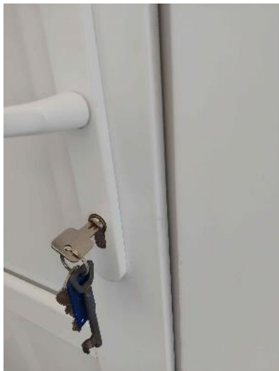
29. Ubytovací objekt – Prádelna sklad 2
