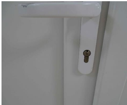
41. Ubytovací objekt – Stravování kuchyn
