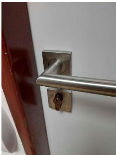
23. Ubytovací objekt – Stravování šatna mužů
