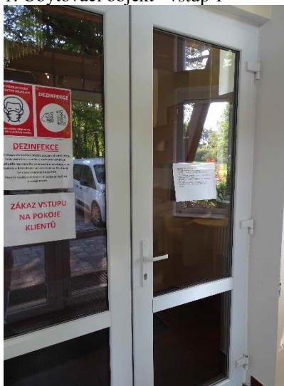
2. Ubytovací objekt –vstup 2
