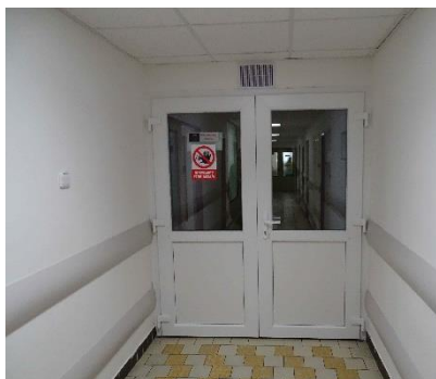
42. Ubytovací objekt – Prádelna vstup 2
