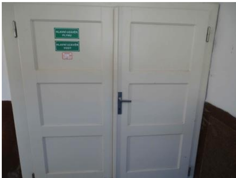
41. Zámek – schodiště VĚŽ 1NP (do 1PP)
