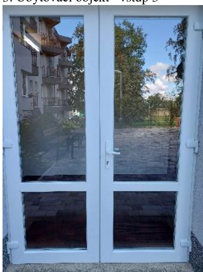
4. Ubytovací objekt –vstup 4
