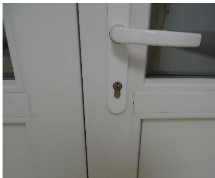
42. Ubytovací objekt – Prádelna vstup 2
