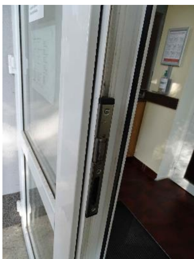
1. Ubytovací objekt –vstup 1
