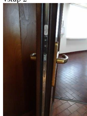
43. Ubytovací objekt – Jídelna
