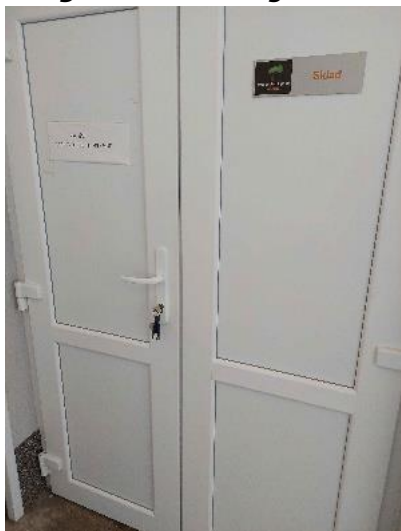
29. Ubytovací objekt – Prádelna sklad 2
