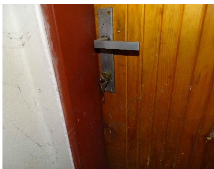
8. Sala Terrena – spodní vstup na schodiště
