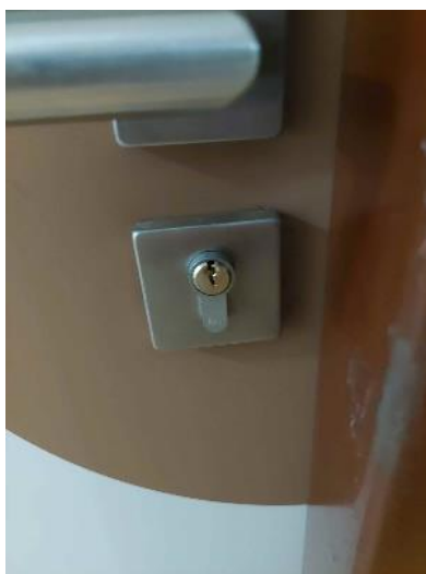
20. Ubytovací objekt – NB sesterna 1
