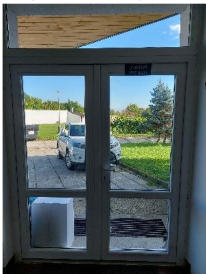
3. Ubytovací objekt –vstup 3
