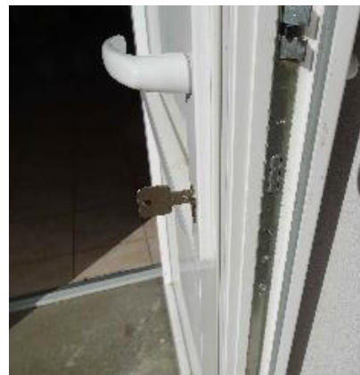
34. Ubytovací objekt – Stravování sklad 3
