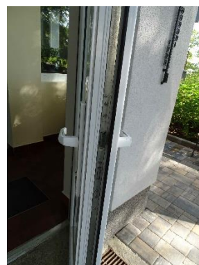
1. Ubytovací objekt –vstup 1
