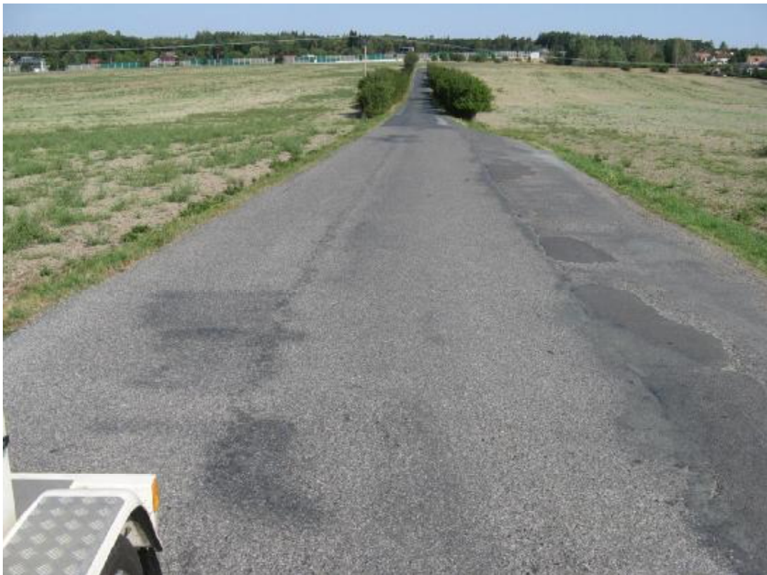
F22 km 1,000- Změna povrchu a rozšíření s vysprávkami.
