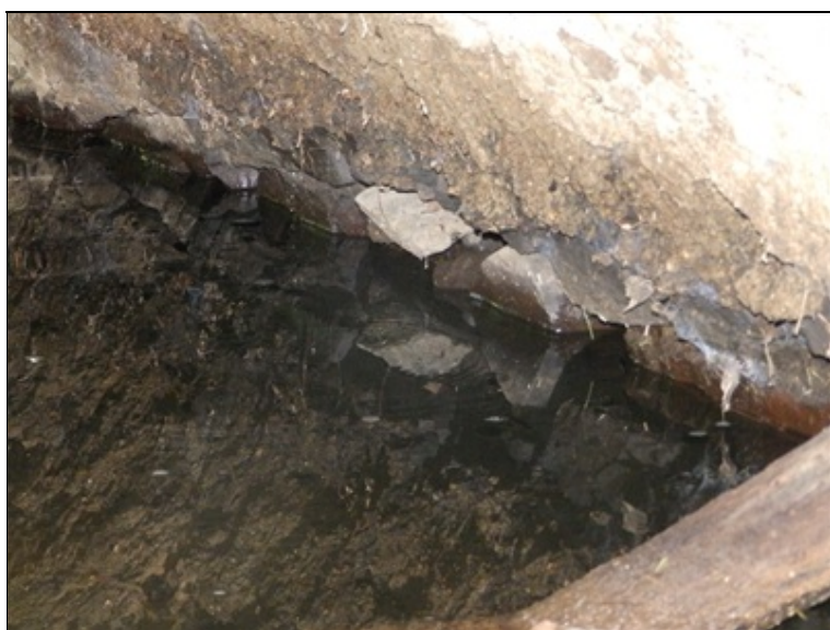
Podemleté zdivo a uvolněné kameny v patní pravé části Op2
