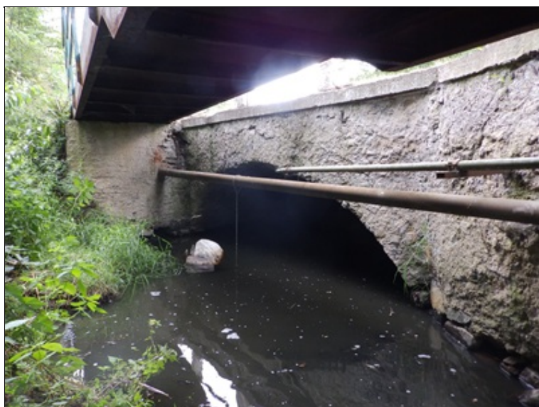
Pohled na pravou stranu mostu
