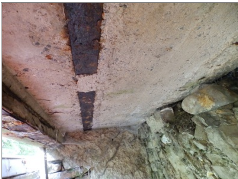
Konstrukce rozšíření na levé straně mostu
