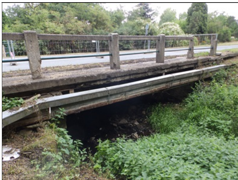
Pohled na levou stranu mostu
