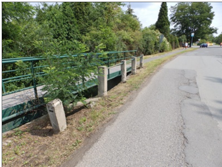
Pohled na zádržné zařízení na pravé straně mostu
