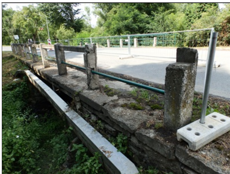
Pohled na zádržné zařízení na levé straně mostu
