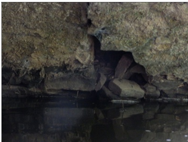
Kaverna a rozvolněné zdivo v pravé části Op2.
