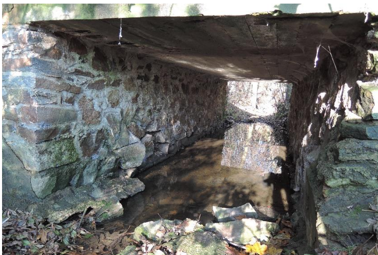
Boční pohled do mostního otvoru
