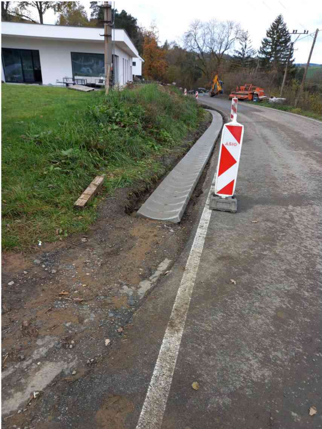
Obrázek 3 – odvodňovací příkop ze žlabových tvárníc
