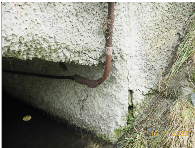
Pravé křídlo OP2 - trhliny a rozpad torkretu.
