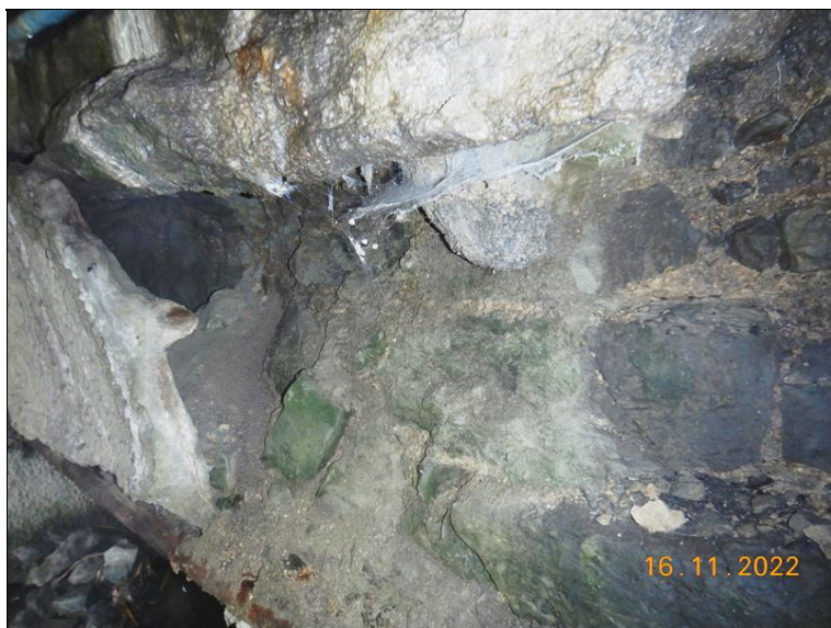
Detail levé čelní zdi - hloubkový rozpad zdiva, odpadající torkret a masivní zatékání.
