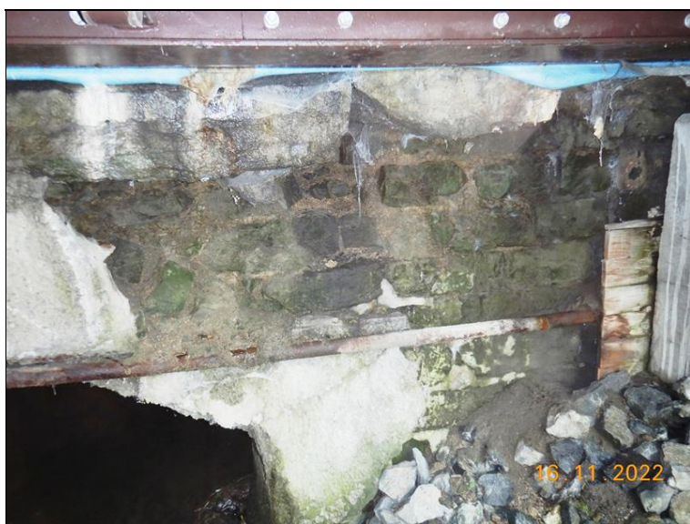
Levé křídlo OP1 - degradace zdiva, masivní zatékání.
