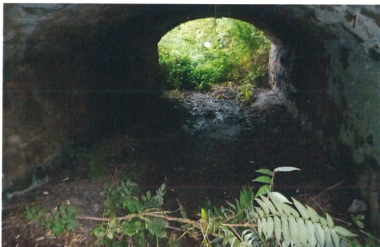
Pohled do mostního otvoru
