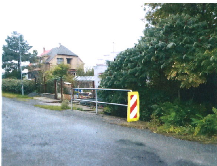
Levá strana mostu a vjezd
