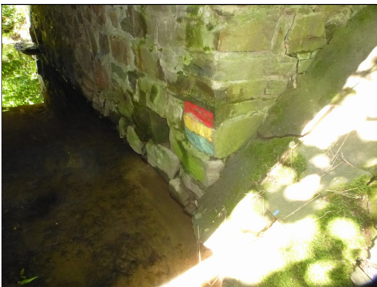
pravá strana opěry 2
