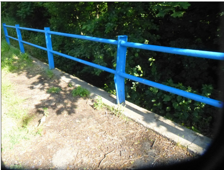
deformace zábradlí
