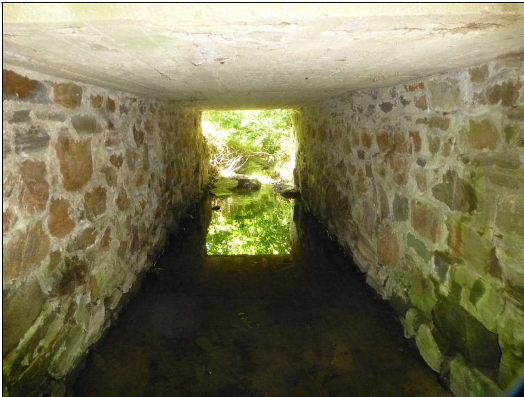
průhled otvorem propustku
