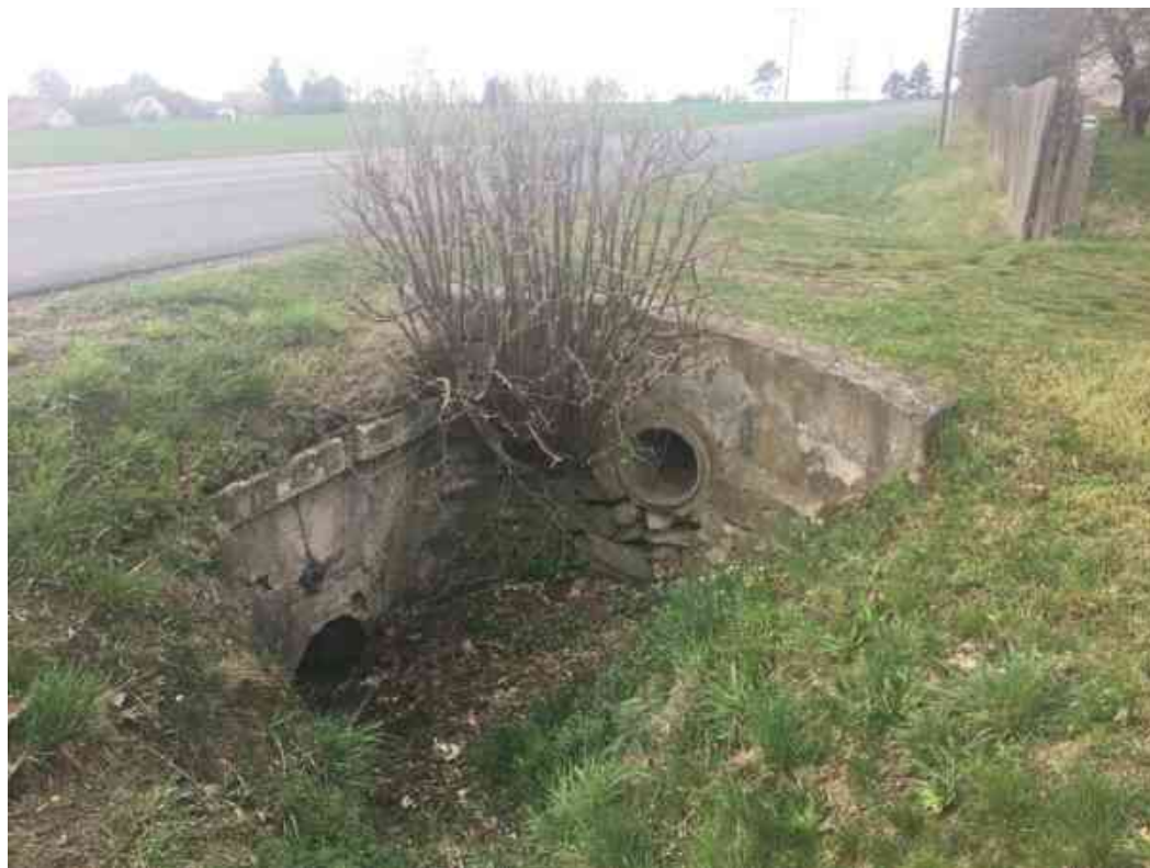
Obr. 4 Propustek 08 – pohled na vtok
