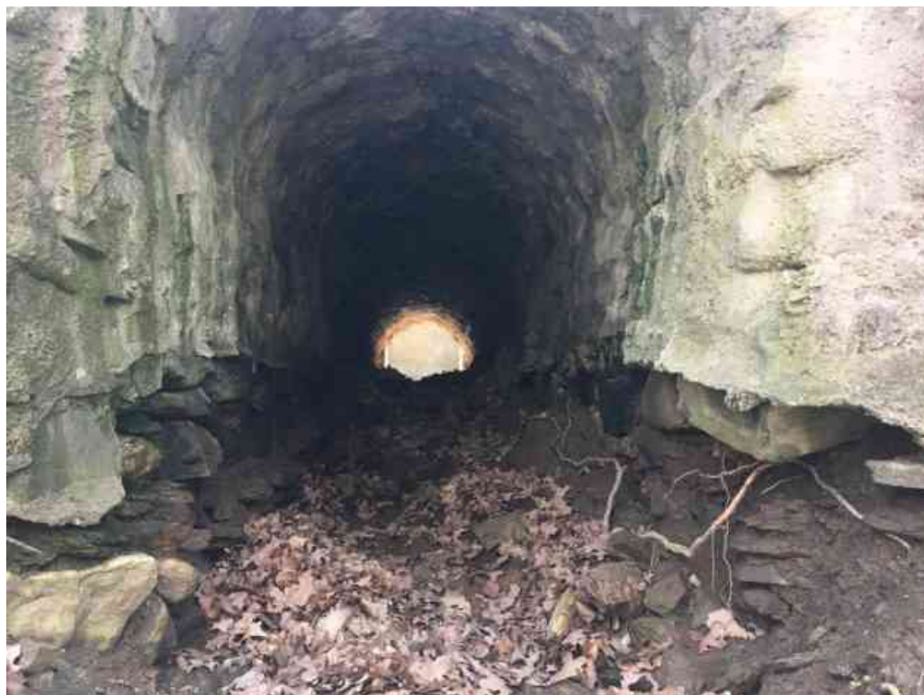
Obr. 1 Propustek 01 – pohled od severu na jih
