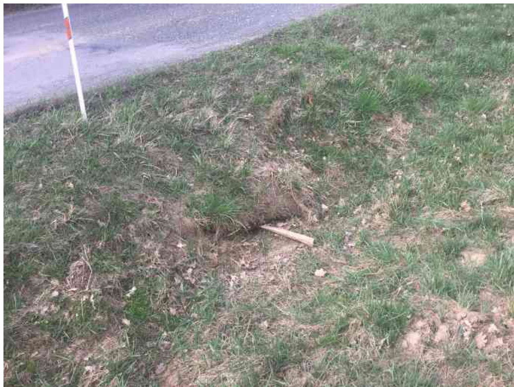
Obr.6 Propustek 10 – pohled na „vtok“
