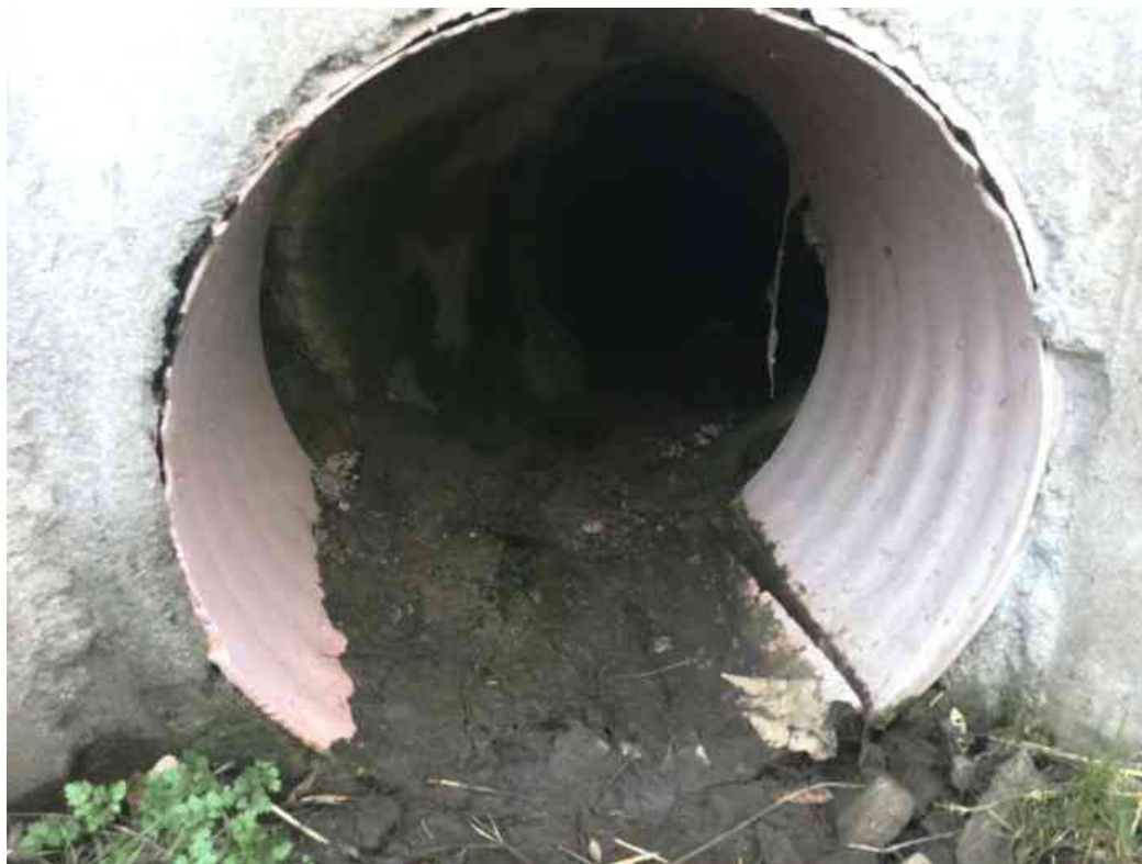
Obr. 5 Propustek 09 – pohled na nastavení trouby plastem na vtoku
