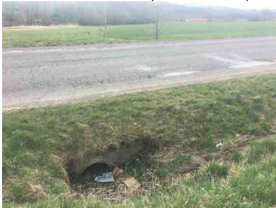
Obr. 3 Propustek 06 – pohled na vtok
