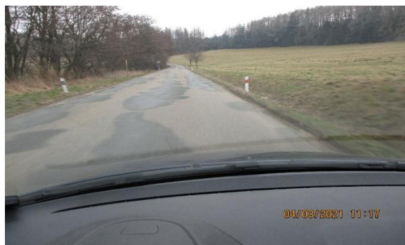
Komunikace II/150 cca v km 25,700
