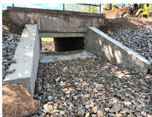
Most 150-005, návodní strana hráze
