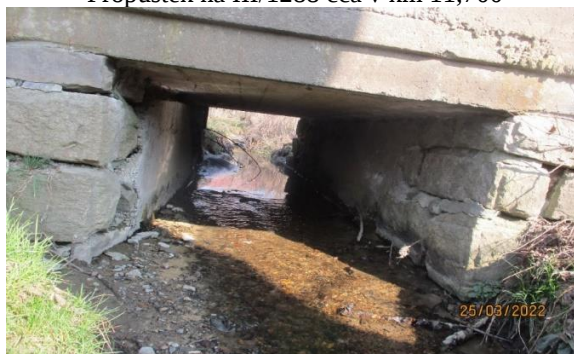
Propustek na III/1288 cca v km 11,700
