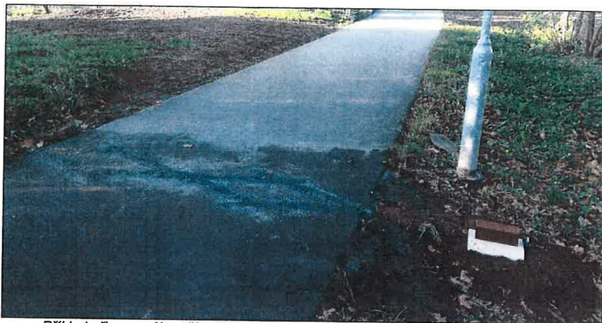
Příklad připraveného sčítacího místa s kovovým boxem chránícím vodiče smyček
