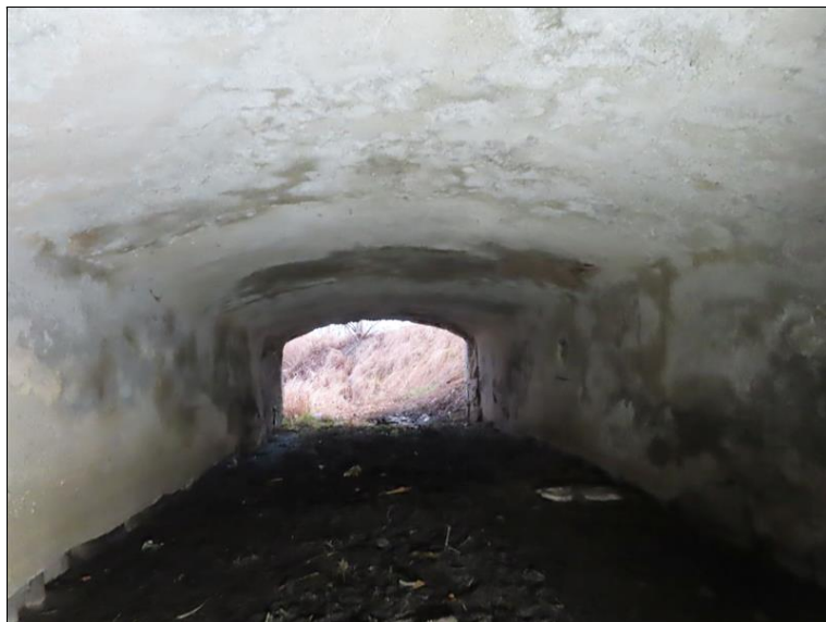
Pohled zleva do 1. pole
