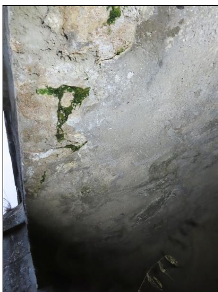
Pohled zleva do 2. pole na vrchol klenby Odpadlý torkret
