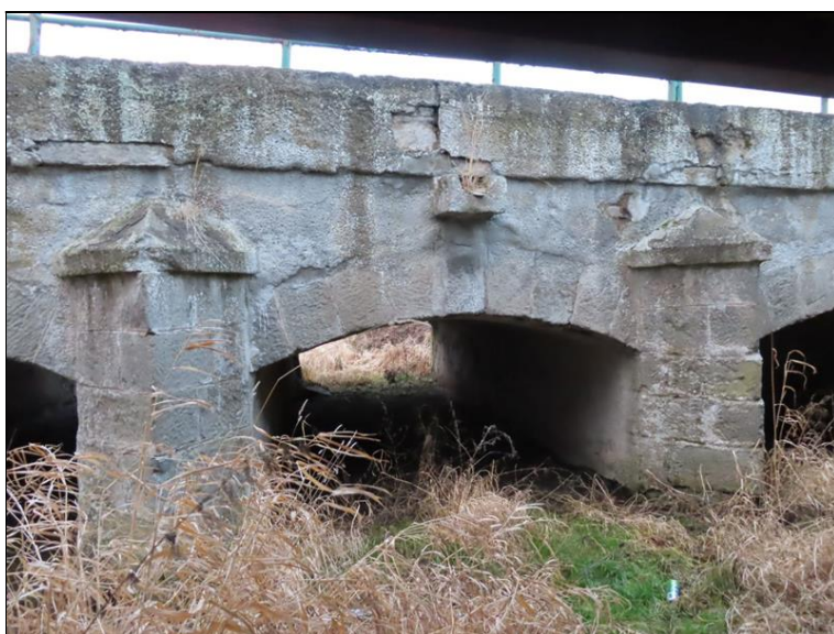
Pohled zleva do 2. pole
