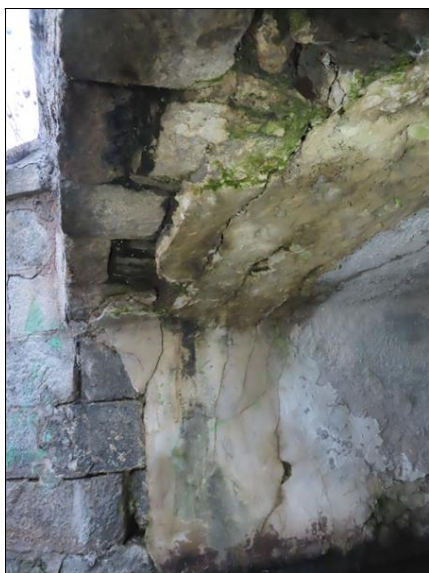
4. pole Pohled směrem k Pi4 Podélné trhliny v torkretu
