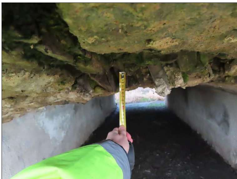
Pohled zprava do 3. pole směrem k Pi4 Čelní zeď - rozvolněna, rozpadající se Svislá průběžná trhлина v ledolamu
