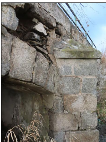
Pohled zprava do 3. pole směrem k Pi4 Čelní zeď - rozvolněna, rozpadající se Svislá průběžná trhлина v ledolamu
