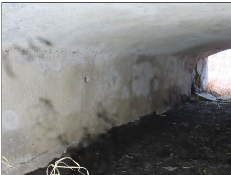
Pohled zleva do 2. pole na vrchol klenby Odpadlý torkret
