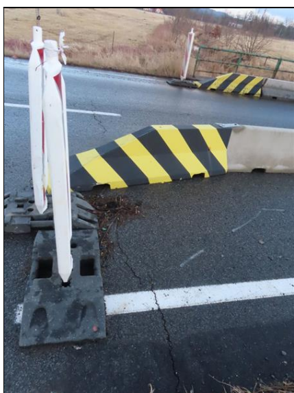
Pohled zleva na konci mostu Vozovka - příčná trhlina
