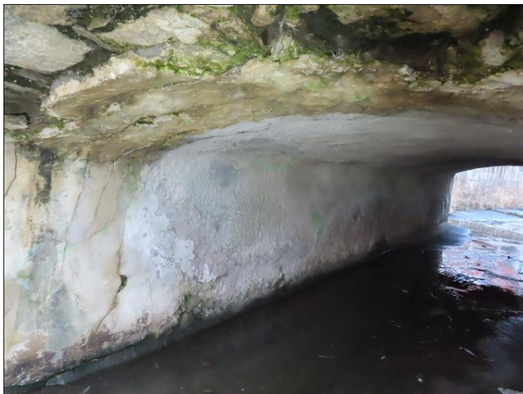
4. pole Pohled směrem k Pi4 Podélné trhliny v torkretu
