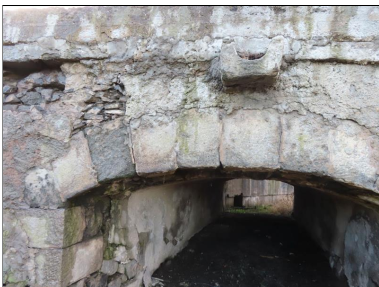
1. pole Pohled z čela
