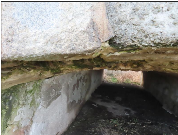
2. pole Pohled směrem k Pi2 Podélná široká trhlina s vypadávajícími kameny
