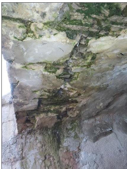
2. pole Pohled směrem k Pi2 Podélná široká trhlina s vypadávajícími kameny
