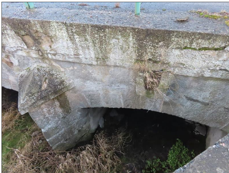
Pohled zleva do 1. pole
