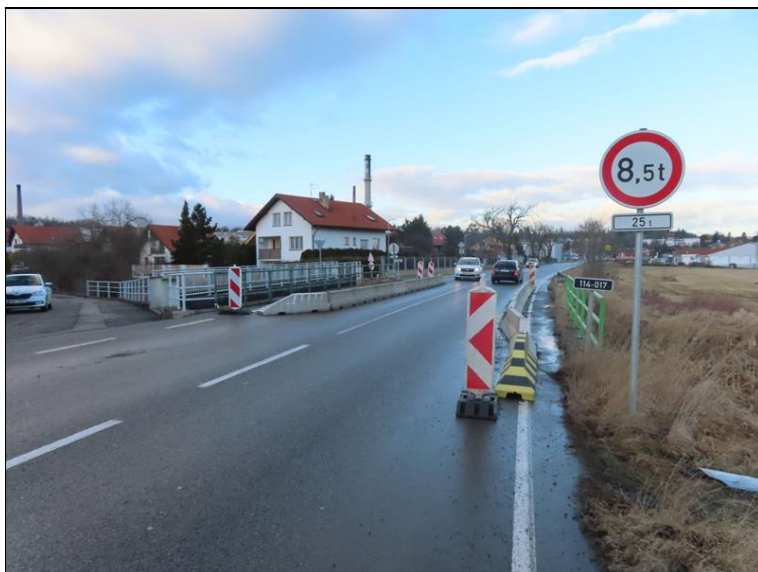
Pohled na uspořádání na mostě po směru staničení
