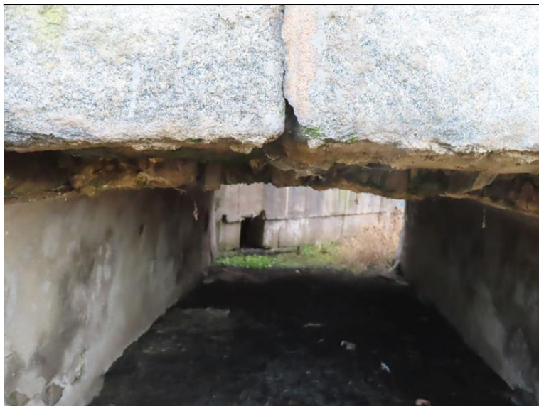
1. pole Pohled z čela Pokles vnitřního klenebního pásu oproti čelní řadě kamenů
