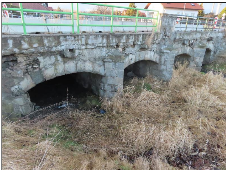
Pohled na most zprava od OP1
