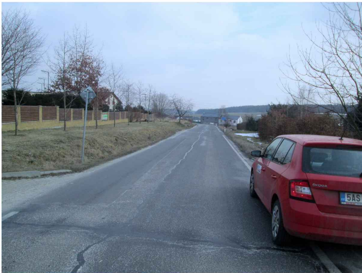
II/116, km 56,900, začátek obce Nová Ves pod Pleší
