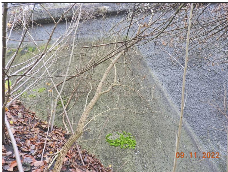
Levé křídlo OP2.
