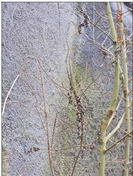
Trhlina v torkretu na rozhraní levé čelní zdi a levého křídla OP1.
