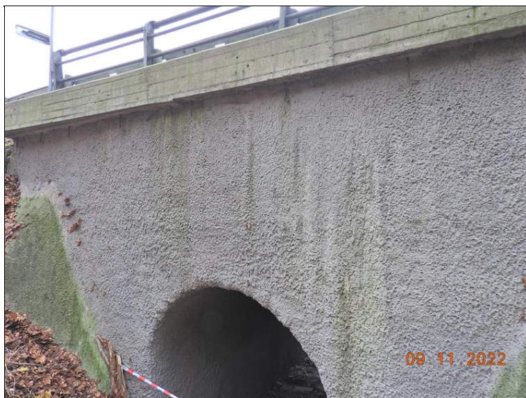
Pravá čelní zeď.
