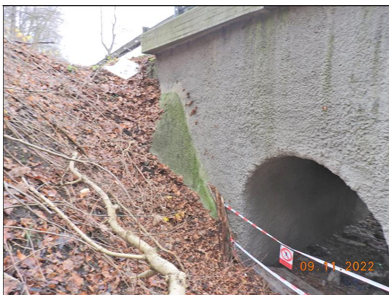
Pravé křídlo OP1.
