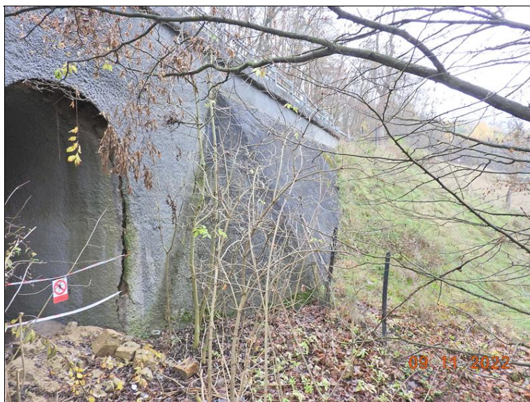
Levé křídlo OP1.
