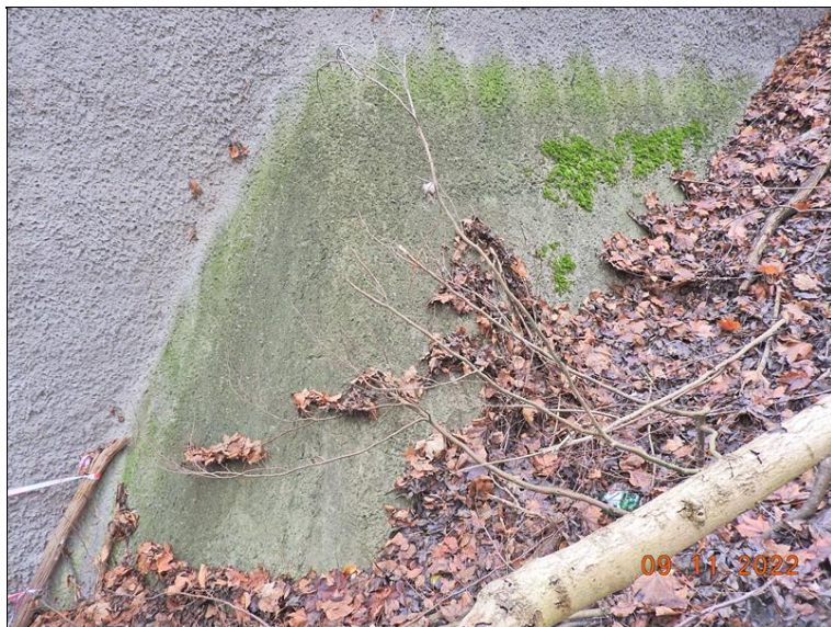
Pravé křídlo OP2.
