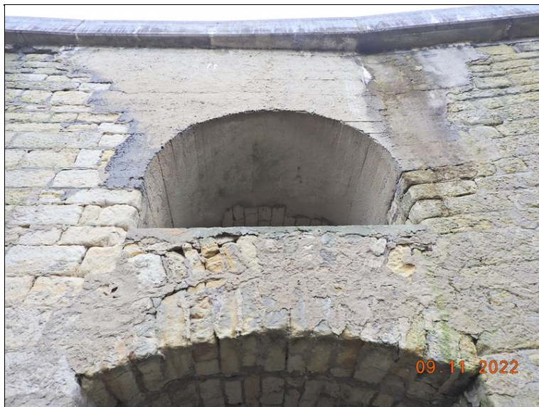
Levá čelní zeď.
