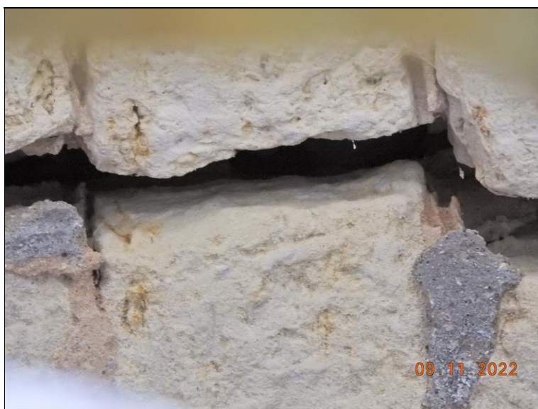
Závažné rozevření spáry v horním patře vlevo.
