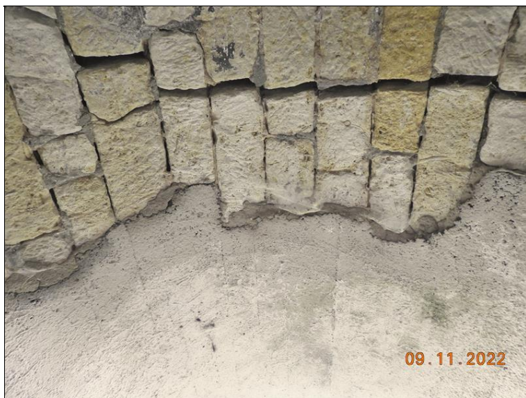
Závažné rozevření spáry v horním patře vlevo.
