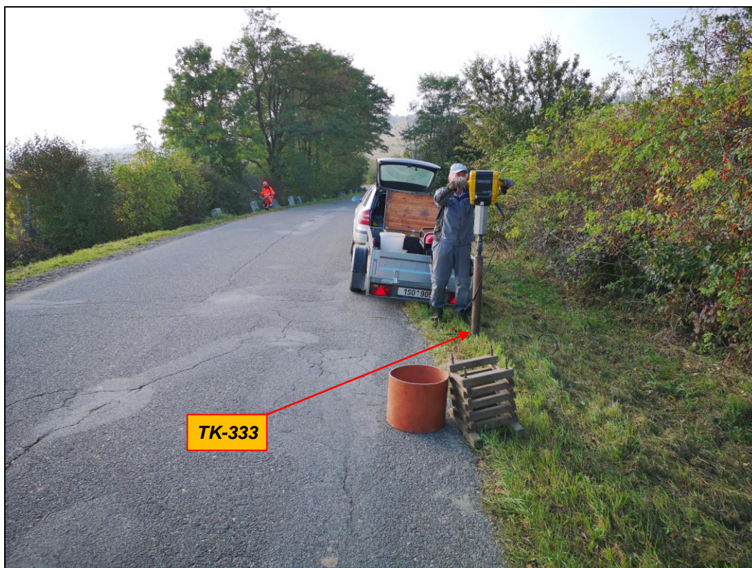
Foto č. 8-9 : Hloubení průzkumných jádrových sond TK-332 a TK-333 elektrickou sondážní soupravou WACKER EH 230/23 (konečná hloubka sond 1,00 m, průměr jádra 80 mm – foto 20.10. 2020)
