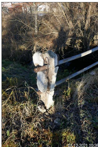
rozlomený betonový sloupek
