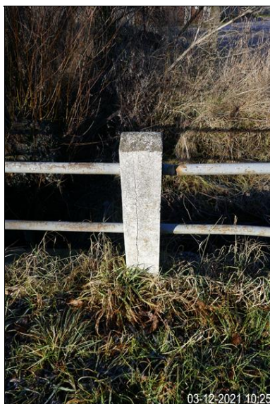
svislá trhlina ve sloupku zábradlí
