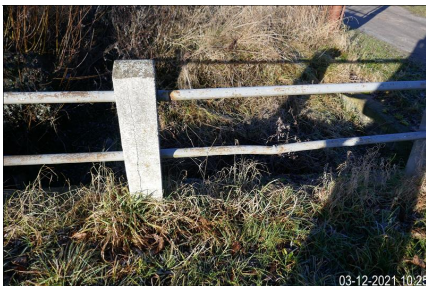
deformace madla zábradlí koroze trhliny ve sloupcích
