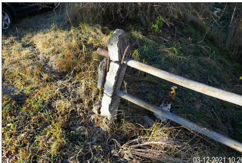
rozlomený betonový sloupek
