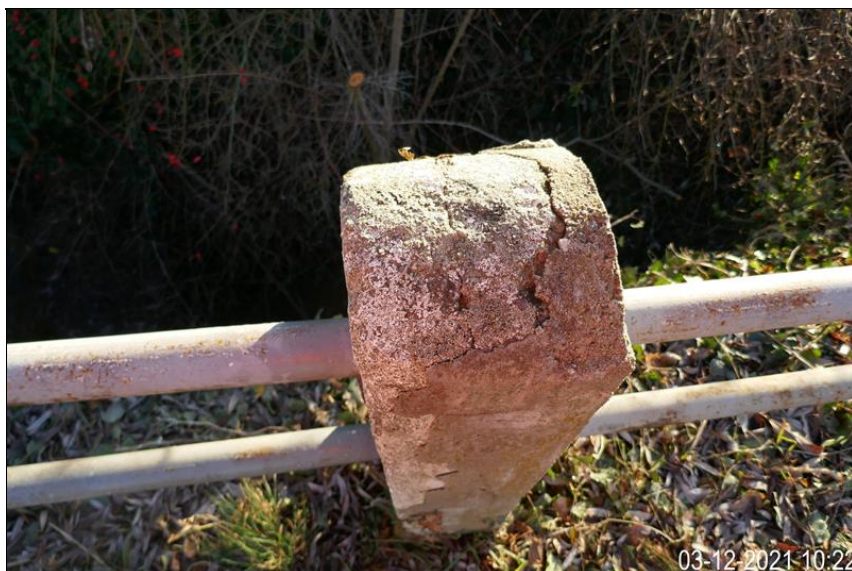
detail sloupku stopy po vysprávkách trhliny
