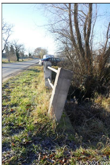
nakloněný sloupek zábradlí za OP2
