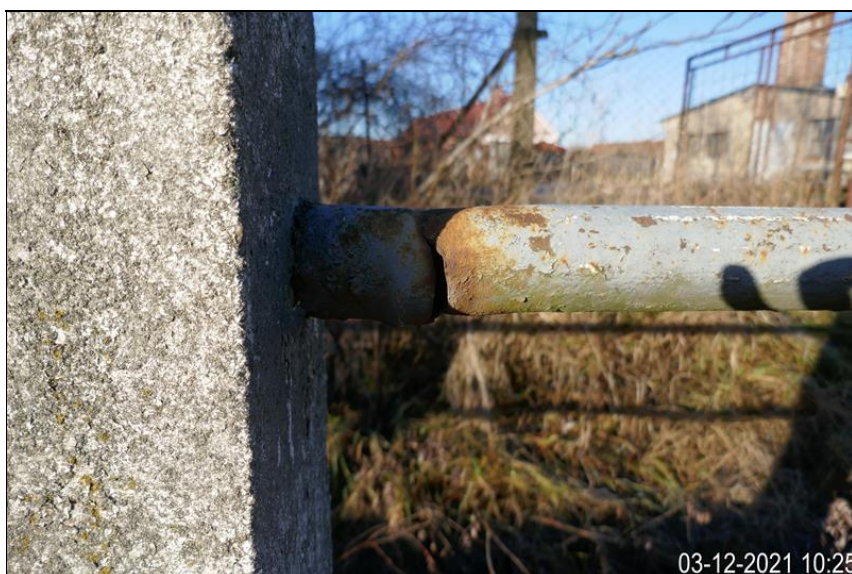
zábradlí deformace poškození ocelového profilu
