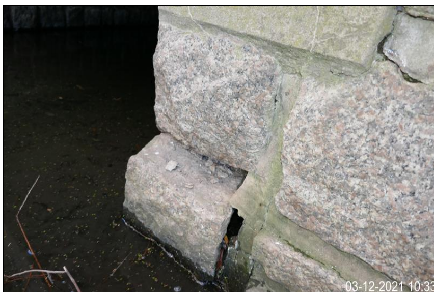
pata opěry uvolněný kamenný blok O1 L strana
