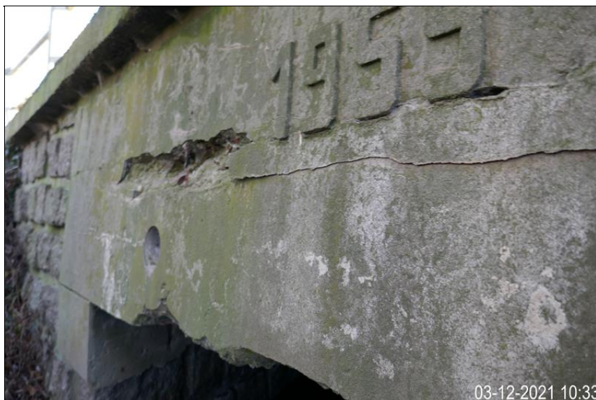
čelní zeď a vývrt po diagnostice
