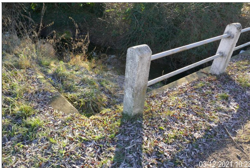
ukončení římsy a zábradlí na pravé římsě za OP2
