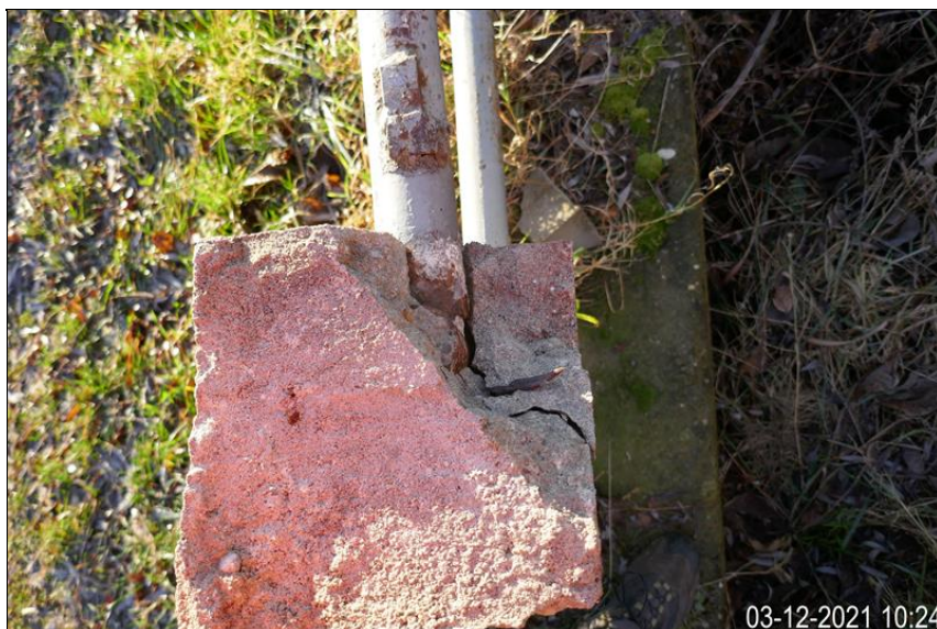
detail poškození sloupku
