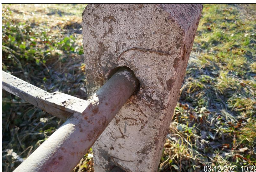
detail koroze zábradlí a upevnění madla ve sloupku
