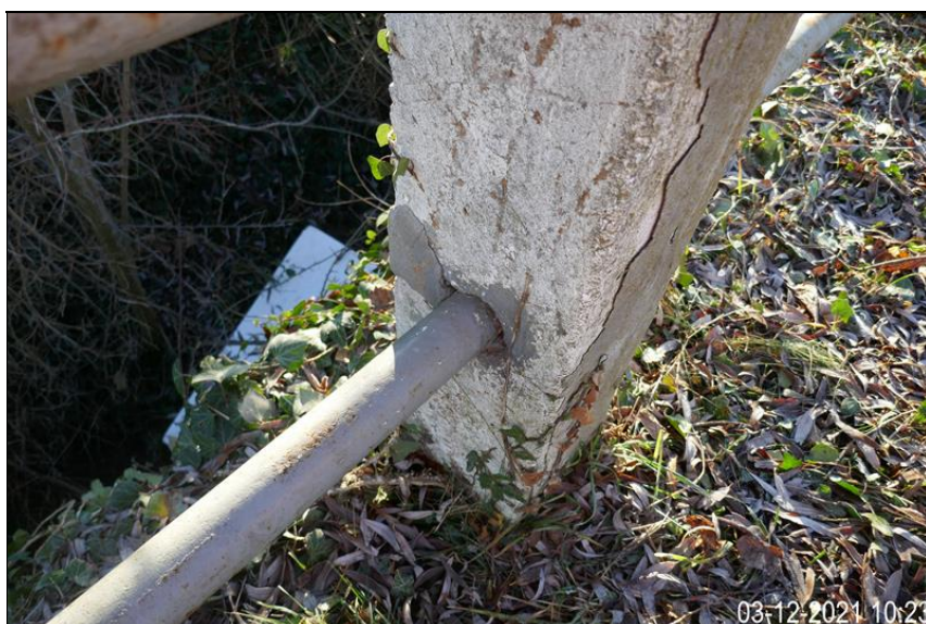
detail sloupku odpadávající omítka
