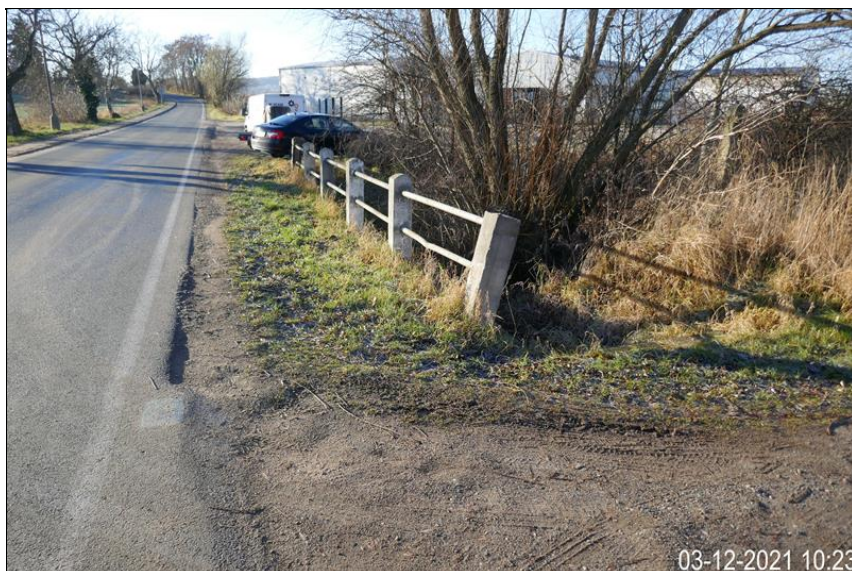
nakloněný sloupek zábradlí za OP2
