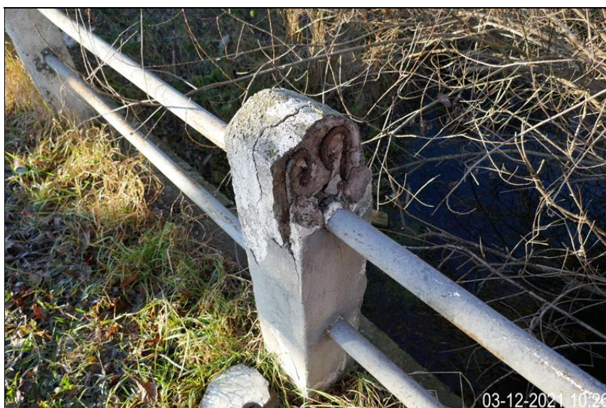
degradované betonové sloupky odpadávající krycí vrstva koroze výztuže trhliny
