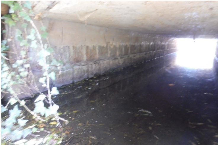
Boční pohled do mostního otvoru
