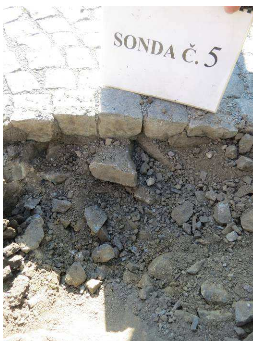
Obr.7.F Sonda č.5 – detail konstrukční vrstvy
