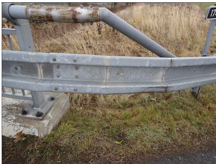
50_koroze madla_poskozena svodnice.JPG
