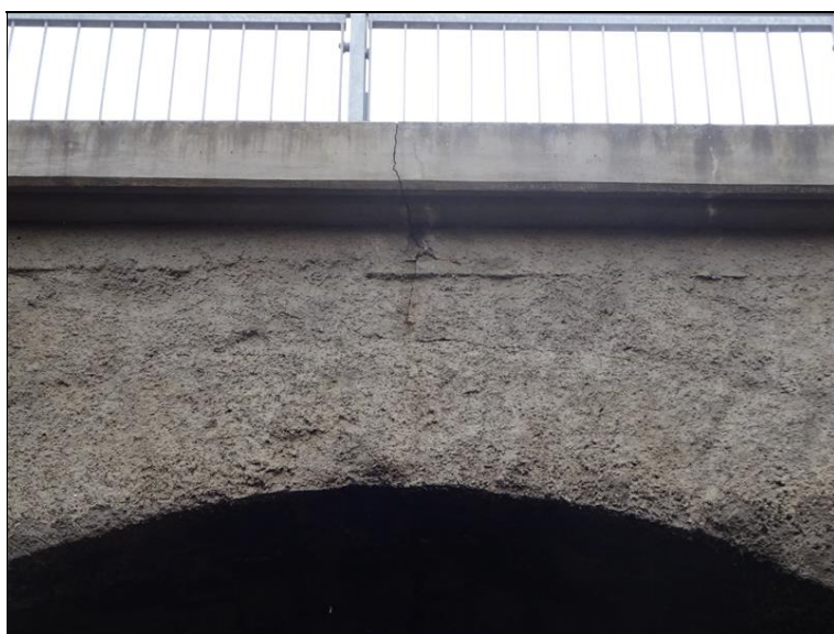
21_trhlina z klenby do římsy.JPG
