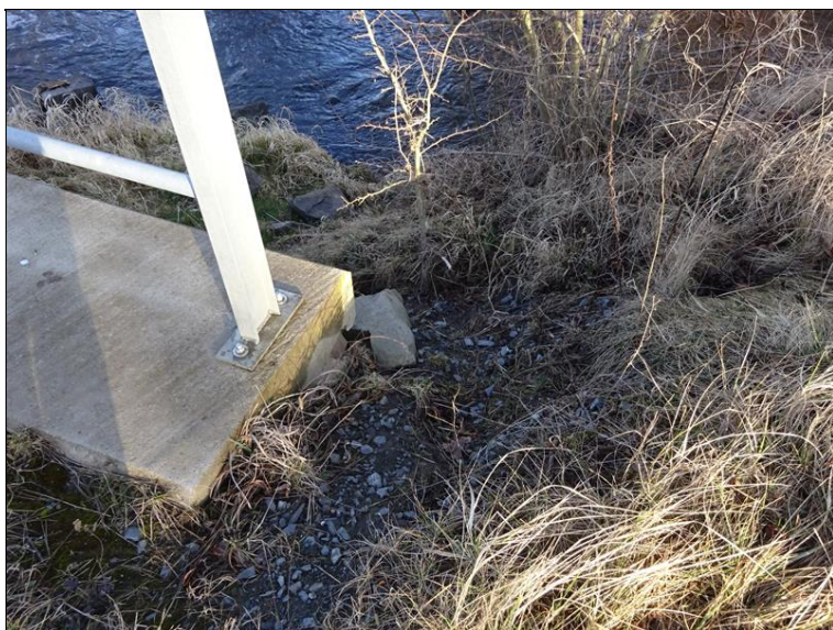
60_vodou_strzena_krajnice_vlevo_za_O2.JPG
