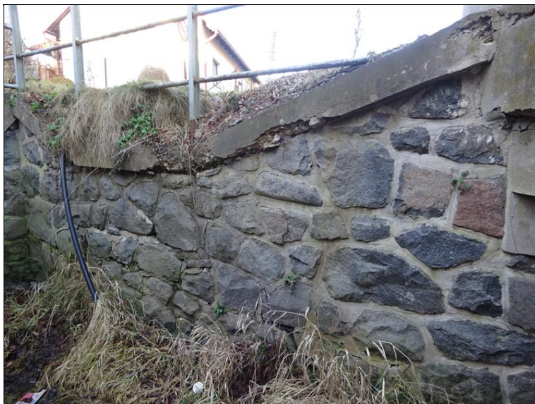
11_kridlo_O1_vpravo_sparovani_rozpadla_rimsa.JPG
