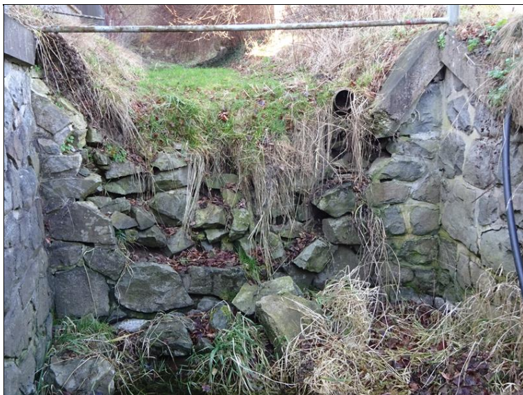
60_rozpadle_zdivo_kaskady_koryta_vpravo.JPG
