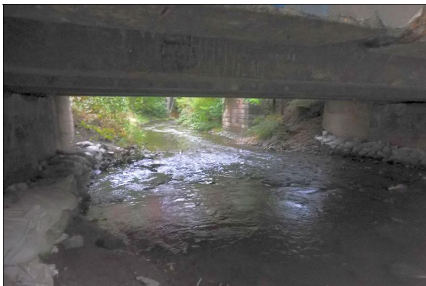
Průhled mostním otvorem.
