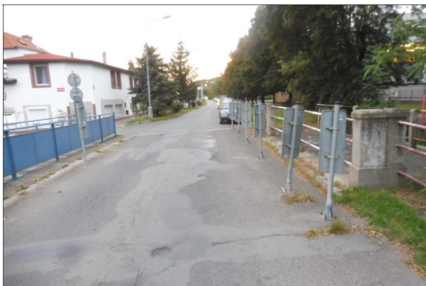
Pohled na most proti směru staničení.
