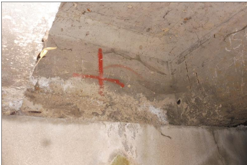
Pohled na spodek nosné konstrukce.
