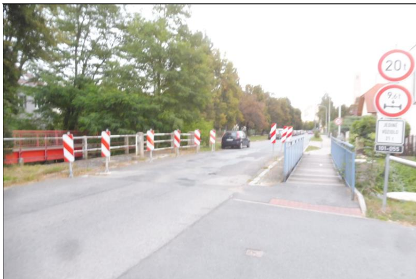
Pohled na most po směru staničení.
