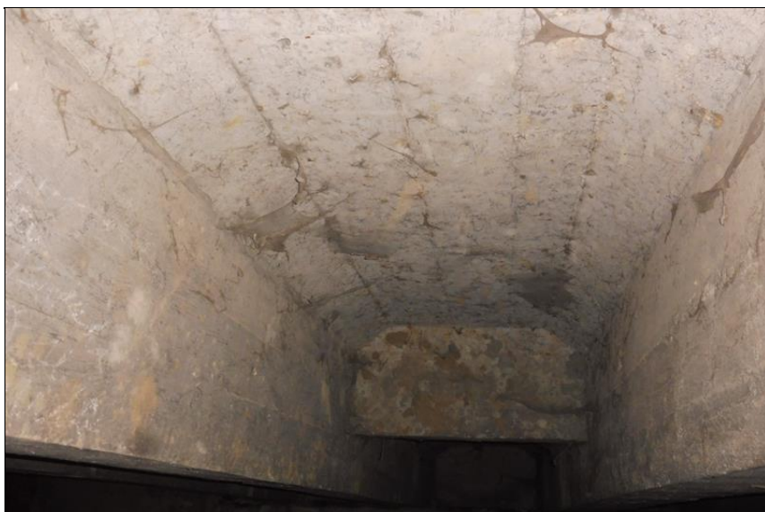
Pohled na spodek nosné konstrukce.
