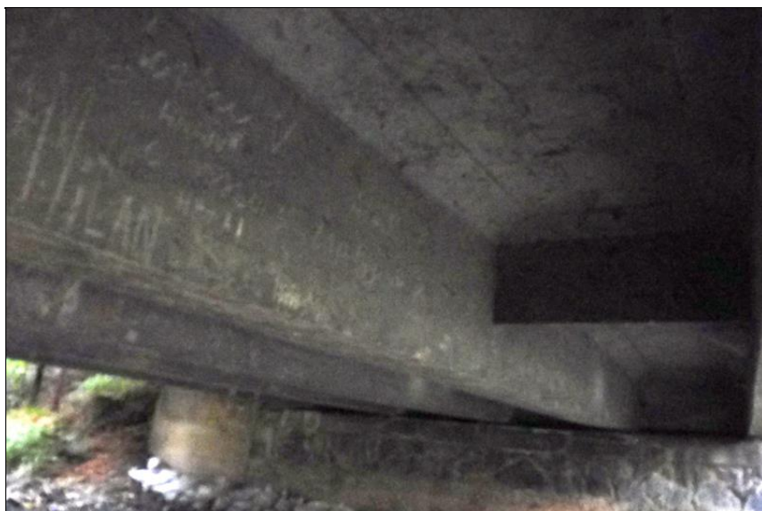
Pohled na spodek nosné konstrukce.
