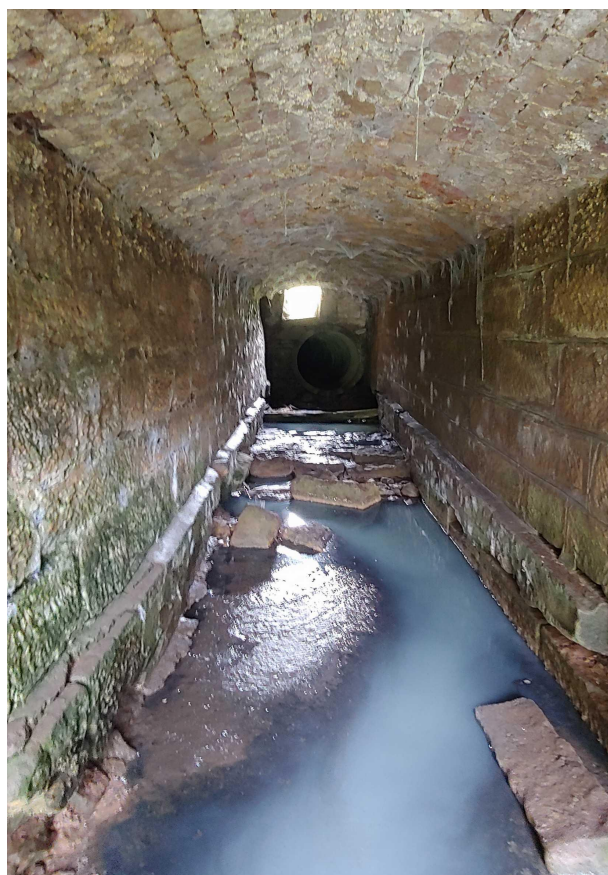
Propustek, pohled proti proudu na ústí Vitického potoka a silničního příkopu
