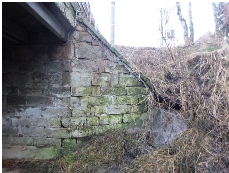
10 OP2 pravé křídlo.JPG
