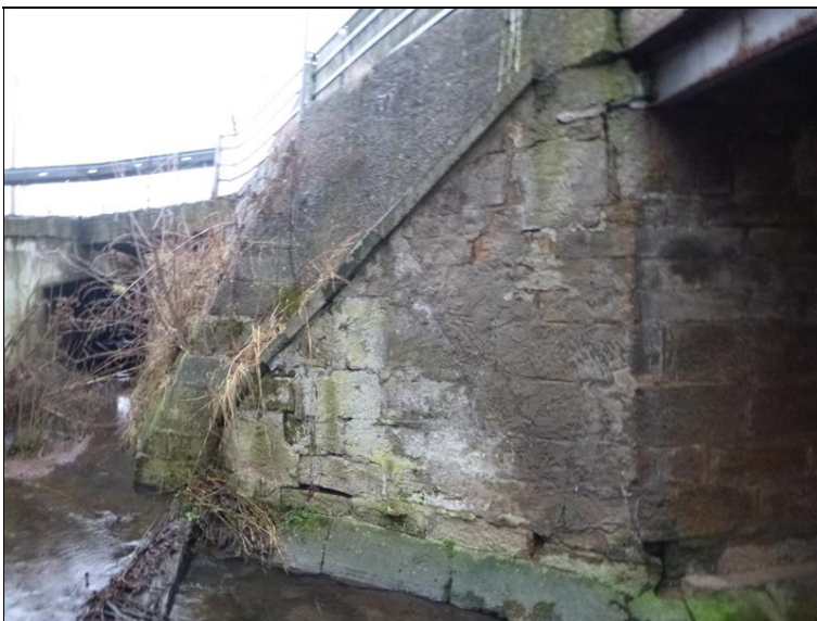
06 OP1 pravé křídlo.JPG
