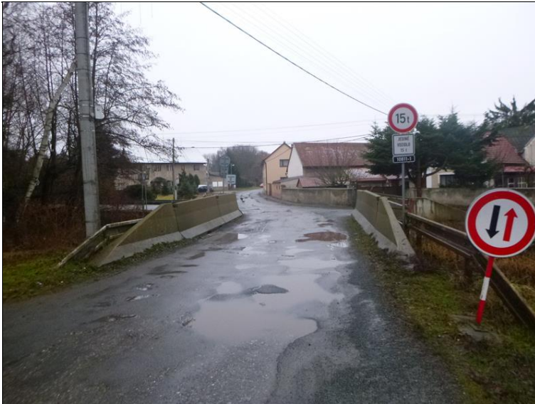
02 proti směru staničení.JPG
