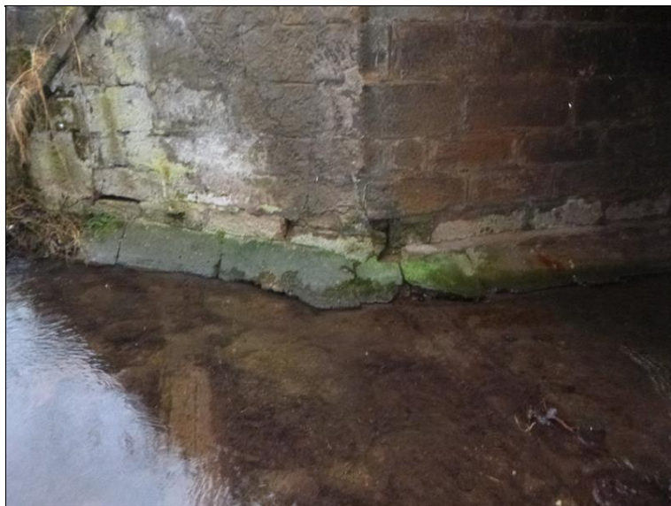
07 OP1 pravé křídlo.JPG
