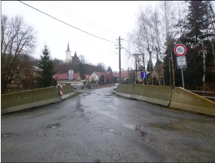
01 po směru staničení.JPG
