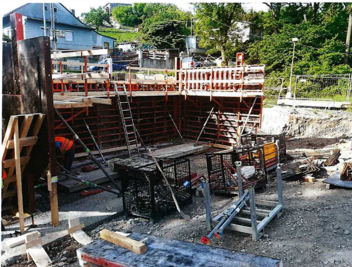
SO 201 MOST – montáž bednění a armatury
