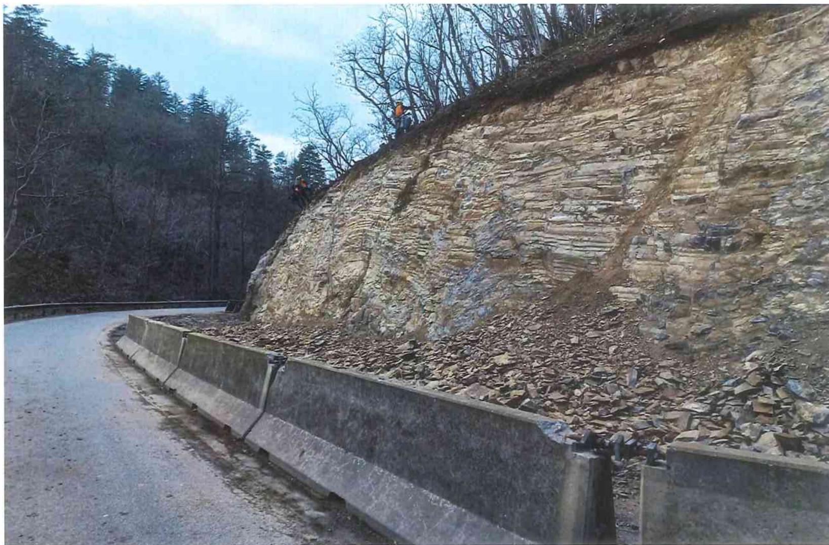
Částečně očištěný svah
