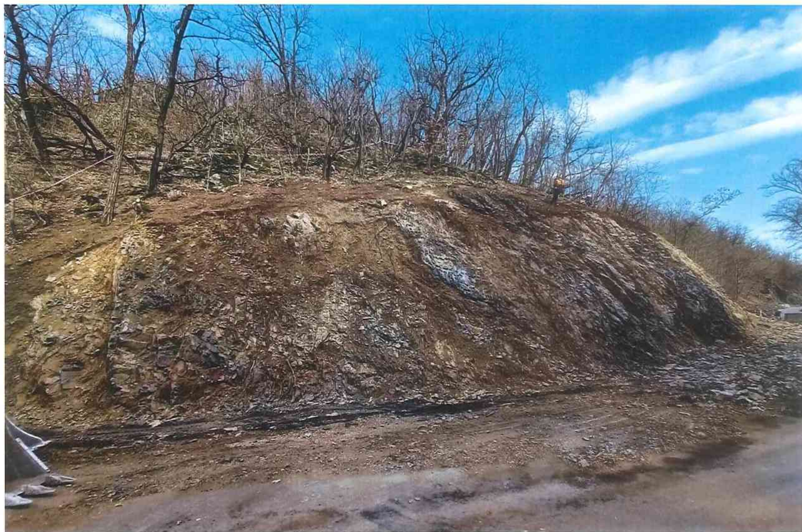
Svah po očištění od vegetace
