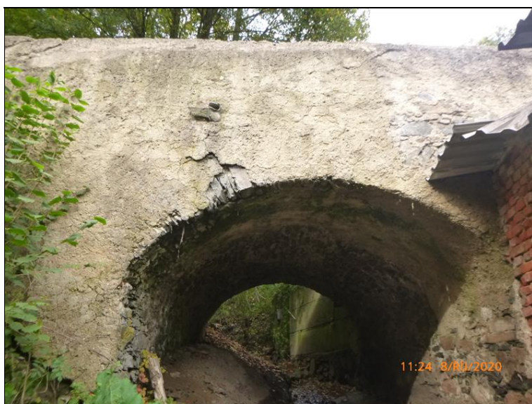
NK - čelní zídka vlevo
